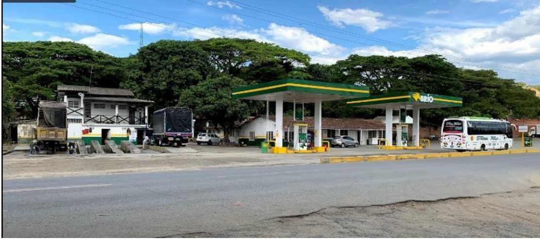
Figura 2. Vista panorámica de la empresa serviteca “Wash & Shine”, Municipio de Zarzal.
