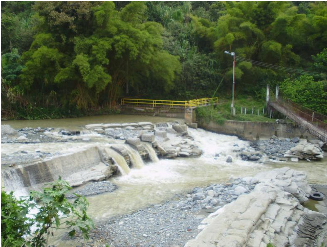
Bocatoma del agua de Buga
