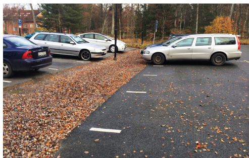
Infiltration vid en parkeringsyta. Foto: Godecke-Tobias Blecken.
