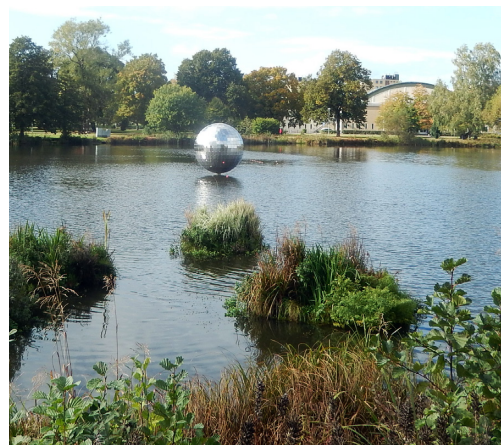
Lagun vid Växjösjön i centrala Växjö – sedimenteringsdamm för rening av dagvatten innan vidare ledning till recipienten. Foto: Göran Nilsson.
