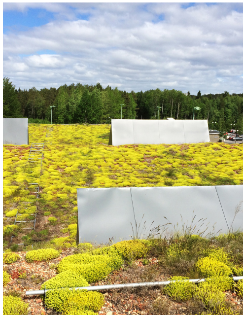
Ett grönt tak på en industribyggnad. Foto: Godecke-Tobias Blecken.
