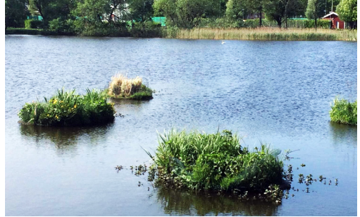
Flytande våtmark i en dagvattendamm.
