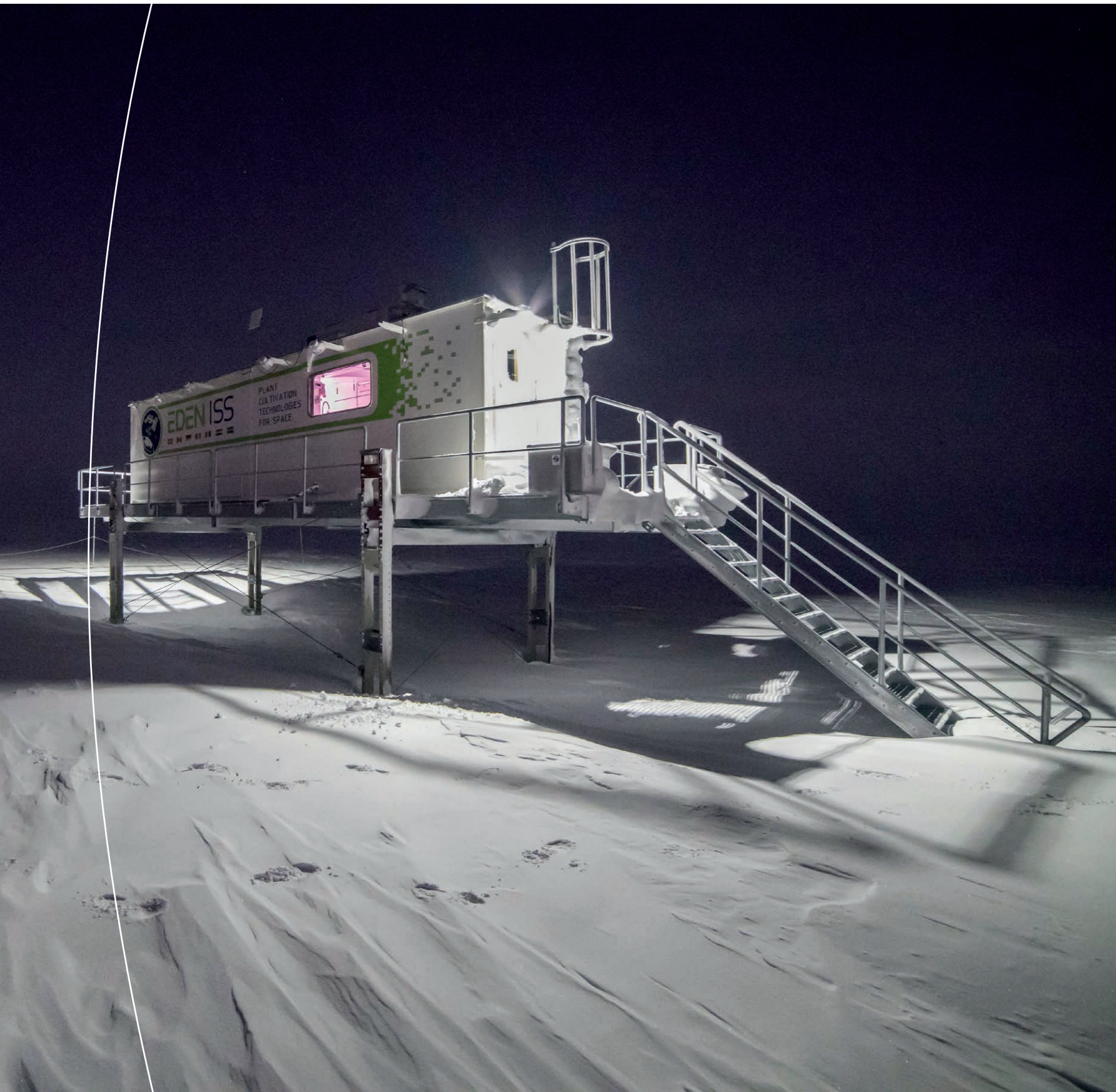
Der Gewächshauscontainer EDEN-ISS in der Antarktis, hier während der Isolationsphase
