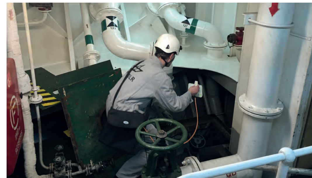
Auch in Industrieanlagen, in denen Satellitendaten nicht empfangen werden können, hilft das neue DLR-System bei der Orientierung
