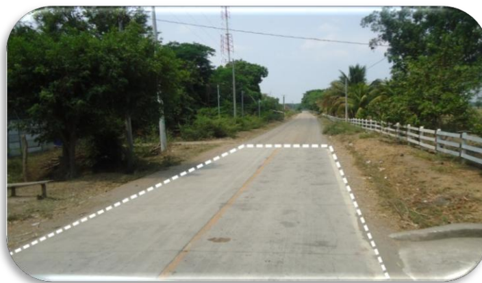
Fotografía 5. Tramo de carretera límite entre el cantón San Nicolás Lempa y San Carlos Lempa.
