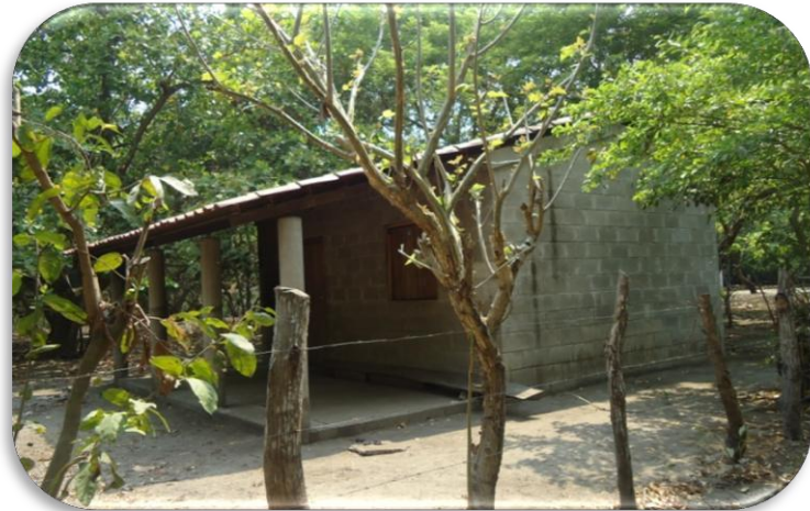
Fotografía 15. Vivienda construida con bloque de concreto y lámina galvanizada en la cubierta. La mayoría de las viviendas poseen esta tipología de vivienda.
