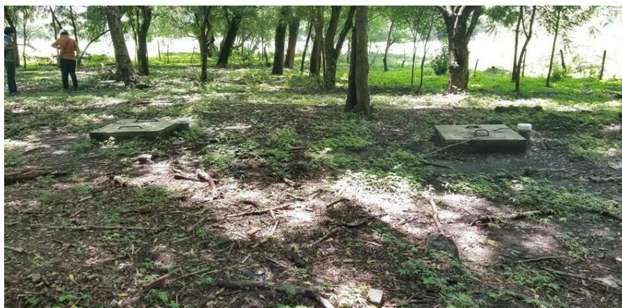
Filtro biológico de los edificios de medicina
