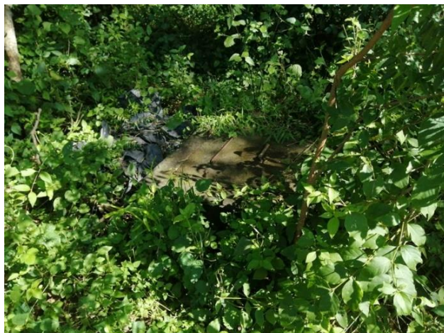
Fosa séptica de aulas de posgrado
