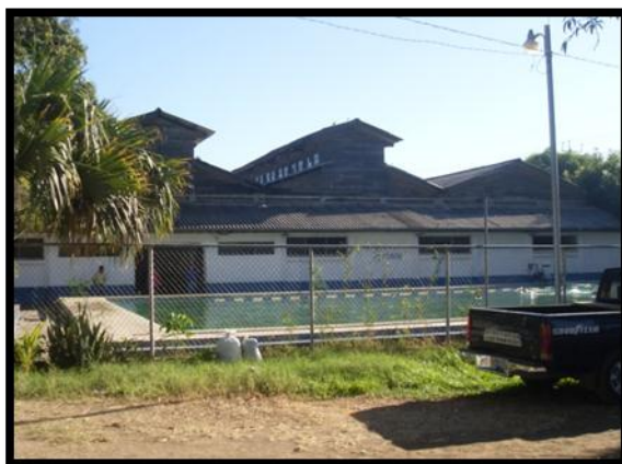
FOTOGRAFIA 4 PISCINA Y ESTRUCTURA DE TECHO DETERIORADOS COSTADO NORTE
