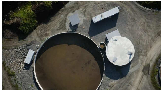
Bilde 3. Dronefoto av biogassanlegg. Bildet viser gasskontainere, blandekum, teknisk container, reaktor, avkjølingskum og biorestlager. Foto: Sparebank 1 SMN
