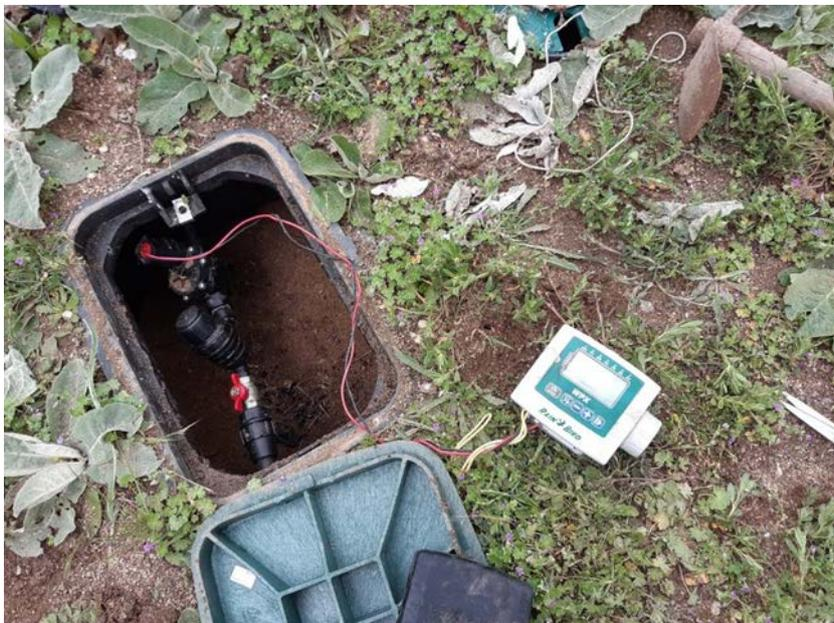
Imagen 4. Programador para el riego automático
