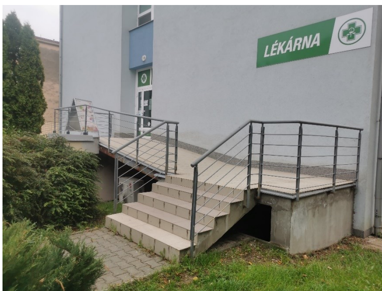
Obrázek 21 Vstup do objektu O1.5 Lékárna v areálu nemocnice
