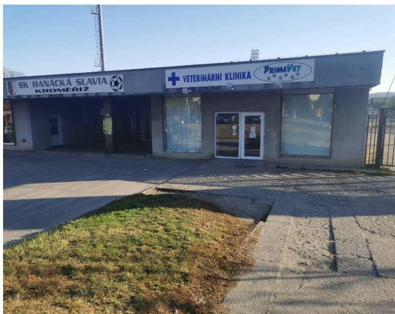
Obrázek 23 Vstup do objektu O3.4 veterinární klinika
