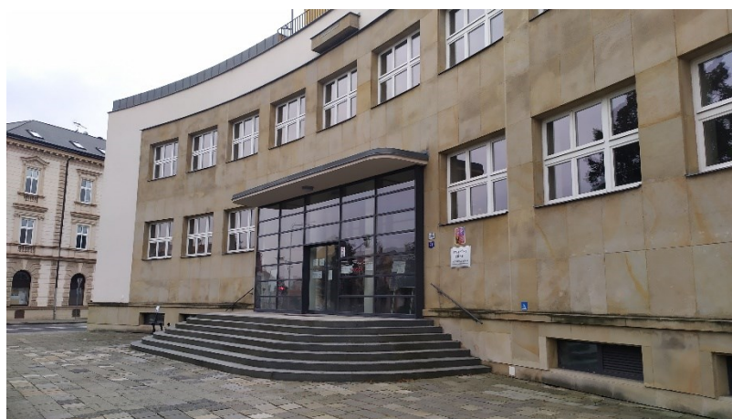
Obrázek 22 Vstup do objektu O2.5 Finanční úřad, Husovo náměstí
