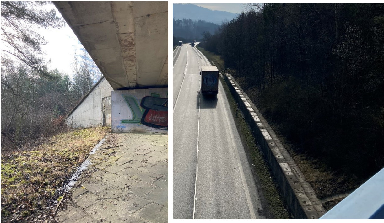
Obrázok 14: Stabilizačné opatrenia na lokalite; vľavo: mostná opora, vpravo: oporný múr
