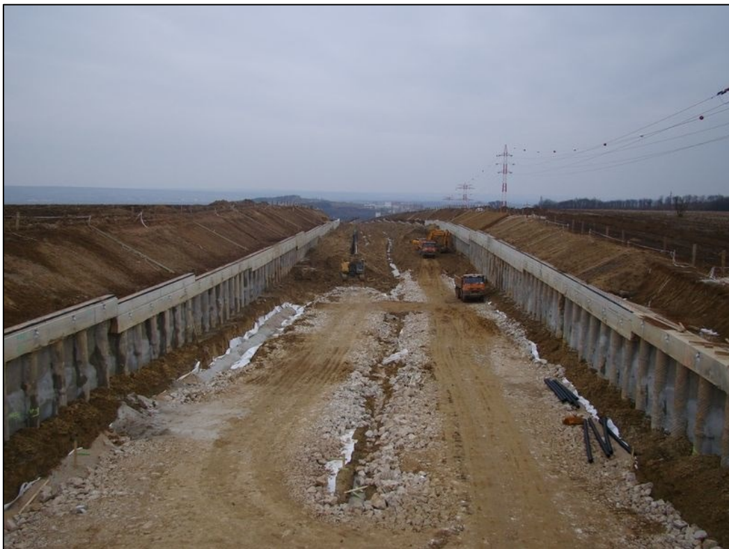
Obrázok 7: Zaistenie zárezu rýchlostnej R1 pilótovými stenami [24]
