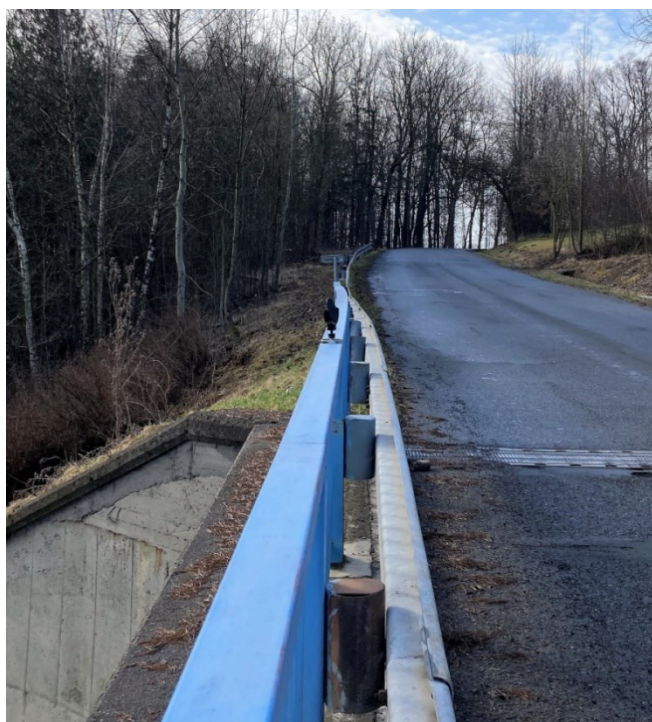
Obrázok 16: Deformované zábradlie a zvodidlo
