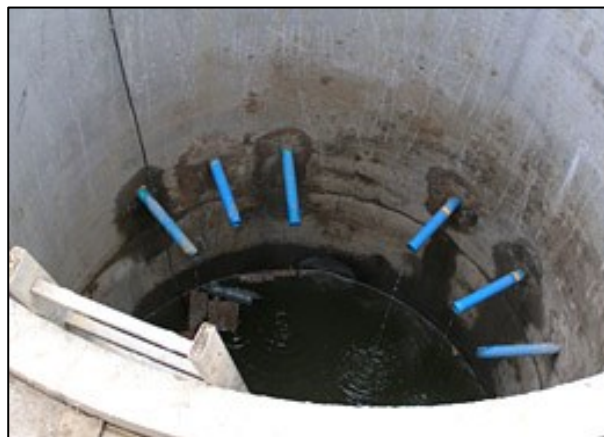
Obrázok 5: Vyústenie horizontálnych odvodňovacích vrtov do šachticy [28]
