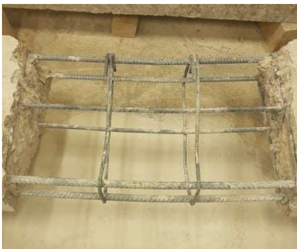
Obrázok 18 Sekaná sonda na železobetónovom nosníku [autor]
