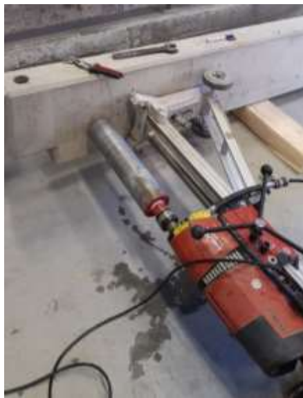
Obrázok 31 - Upevnenie jadrovej vŕtačky na nosník [autor]
