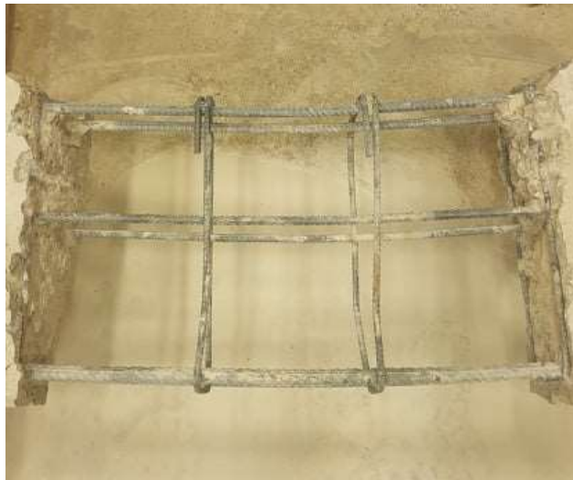
Obrázok 36 - Odhalenie výstuže sekanou sondou [autor]
