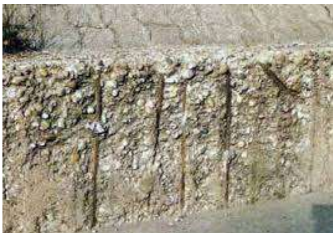
Obrázok 10 - Korózia podporená pôsobením chloridov [19]
