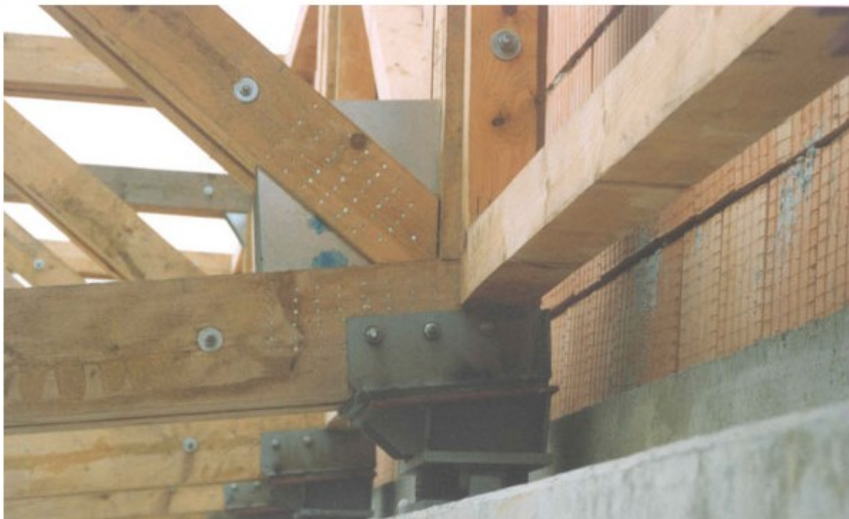
Obrázek 2-25. Spoj s vloženými ocelovými plechy a kolíky. [14]
