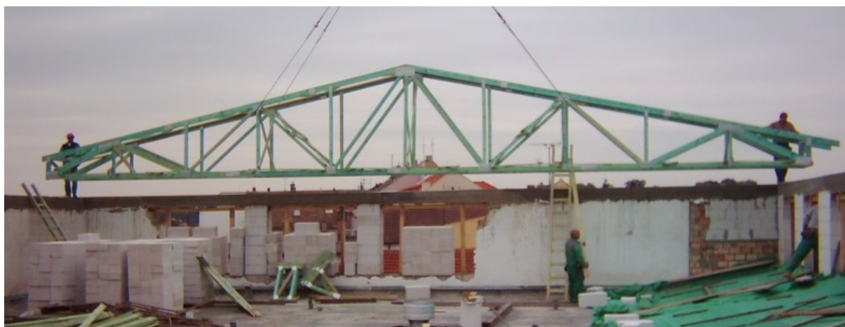
Obrázek 2-11. Dřevěný příhradový vazník lichoběžníkového tvaru [7].
