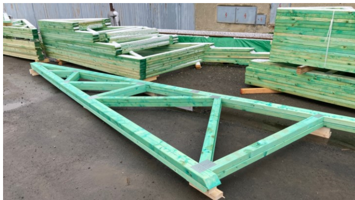
Obrázek 2-22. Montážní dílce vazníku nachystané pro přepravu. Foto vlastní z návštěvy firmy [12].
