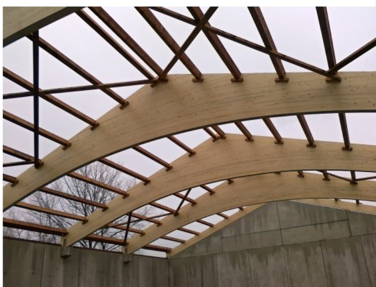
Obrázek 2-10. Ukázka plnostěnného vazníku se zakřiveným spodním pásem [6].
