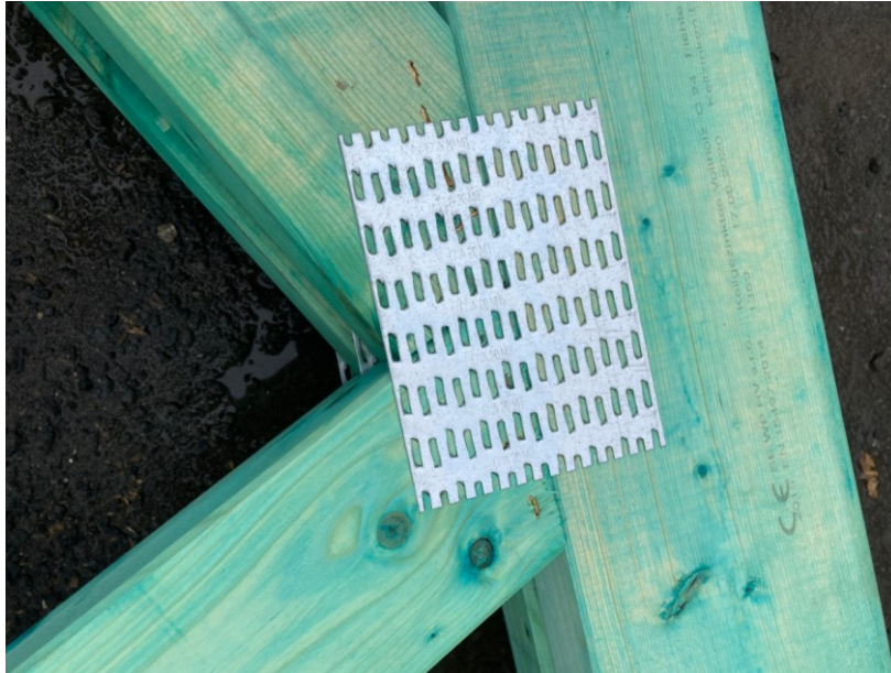
Obrázek 2-19. Spoj desky s prolisovanými trny. Foto vlastní z návštěvy firmy Střechy POTÁČEK [12].
