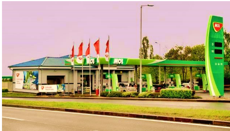
Obr. 3.4 Čerpací stanice společnosti MOL Zdroj: [25]
