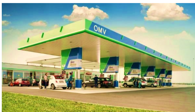
Obr. 3.6 Čerpací stanice značky OMV Zdroj: [27]
