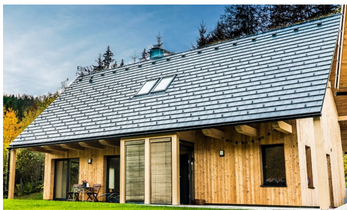
Obrázek 2-26. Rodinný dům v Beskydech – CLT systém [19].
