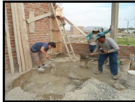
Ensayo de consistencia
