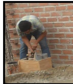
Elaboración de Probetas de Concreto
