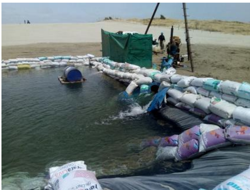
Foto N°01. Pruebas de bombes SANTA REGINA S.A.C.
