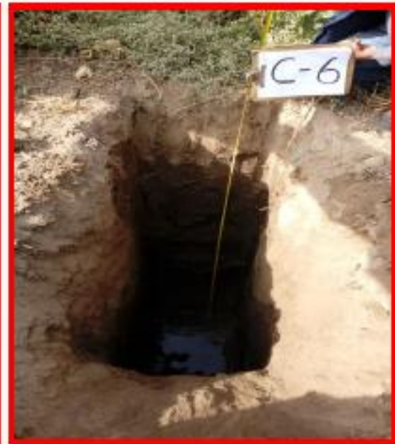
Foto N° 12. Presencia de Napa Freática en calicata C-6.
