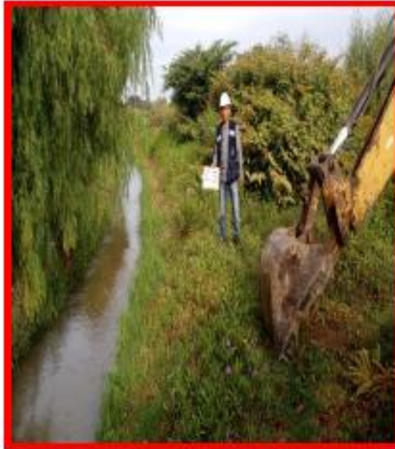
Foto N° 5. Ubicación y Apertura de calicata C-3.
