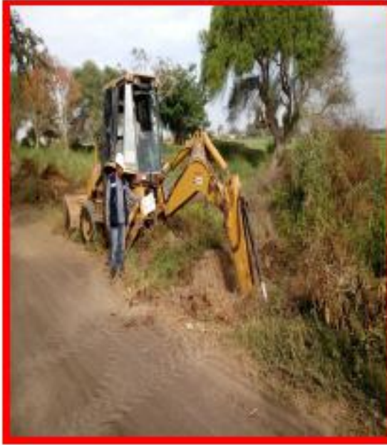
Foto N° 9. Ubicación y Apertura en Calicata C-5.
