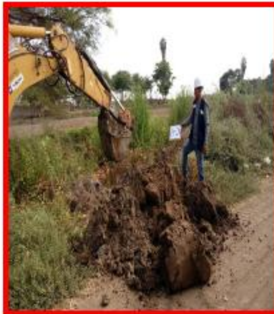
Foto N° 11. Ubicación y Apertura en La calicata C-6.
