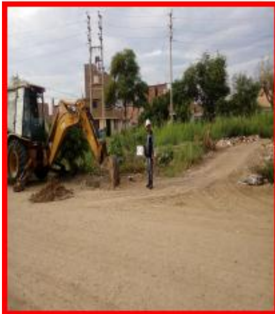
Foto N° 1. Ubicación y apertura de Calicata C-1.
