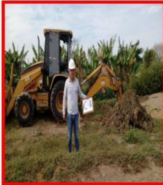
Foto N° 17. Ubicación y Apertura en Calicata C-8.
