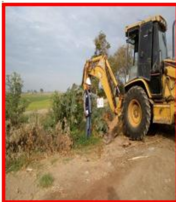
Foto N° 3. Ubicación de Calicata
