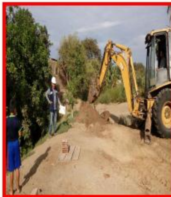
Foto N° 7. Ubicación y Apertura de calicata C-4
