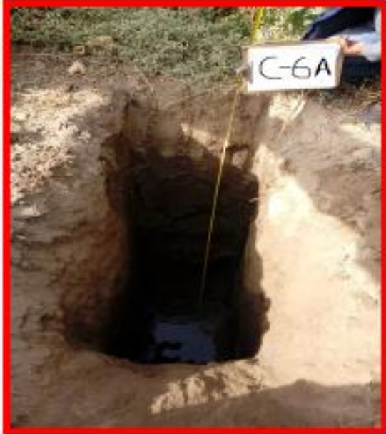
Foto N°14. Presencia de napa freática en la Calicata C-6A
