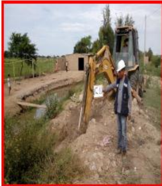
Foto N° 21. Ubicación y apertura del suelo en Calicata C-10.
