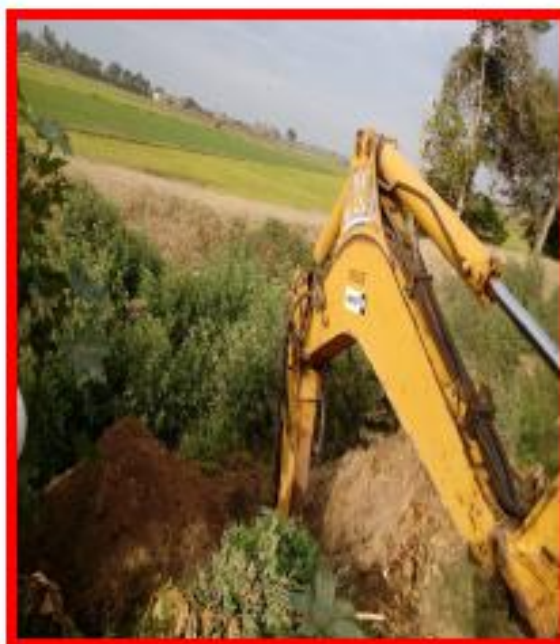
Foto N° 4. Apertura de calicata C-2.
