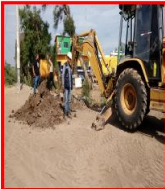
Foto N° 15. Ubicación y Apertura de Calicata C-7.
