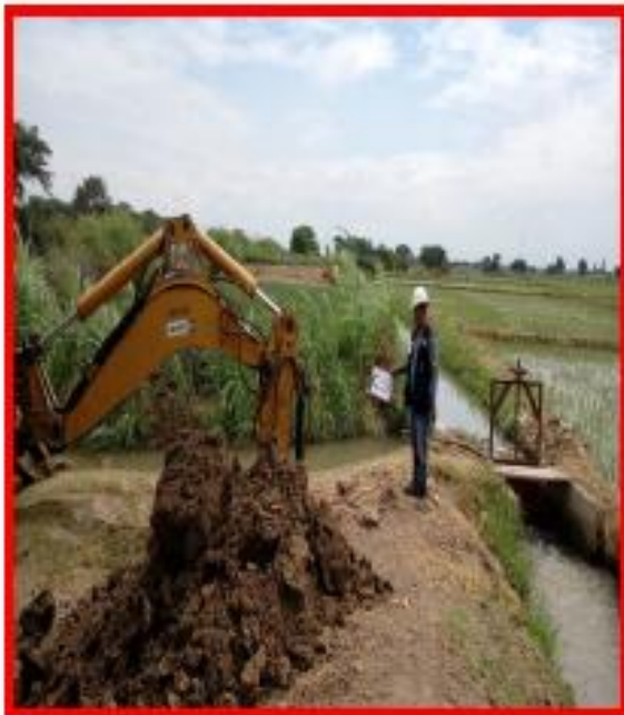
Foto N° 27. Ubicación y apertura del suelo En C-13
