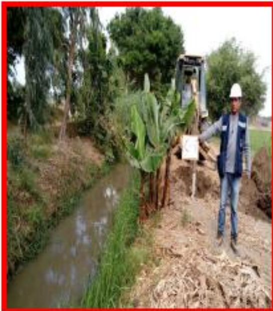
Foto N° 19. Ubicación y Apertura en Calicata C-9.
