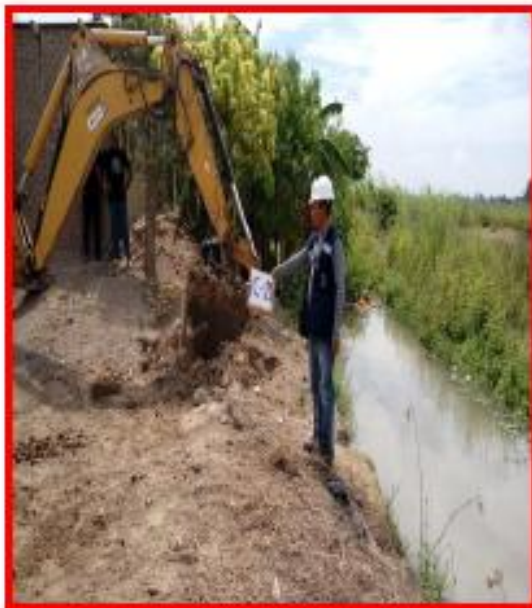
Foto N° 23. Ubicación y apertura del suelo en Calicata C-11.
