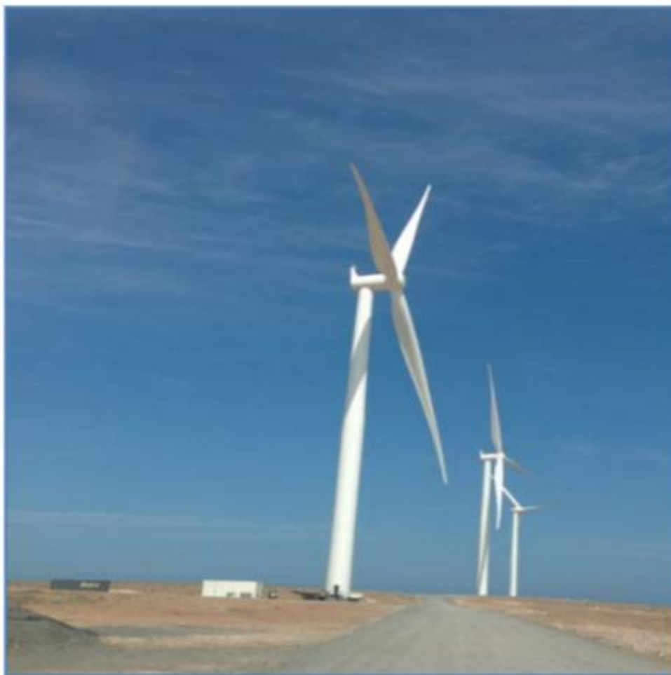
Figura 29: Vista de los aerogeneradores de la C.E. Marcona
