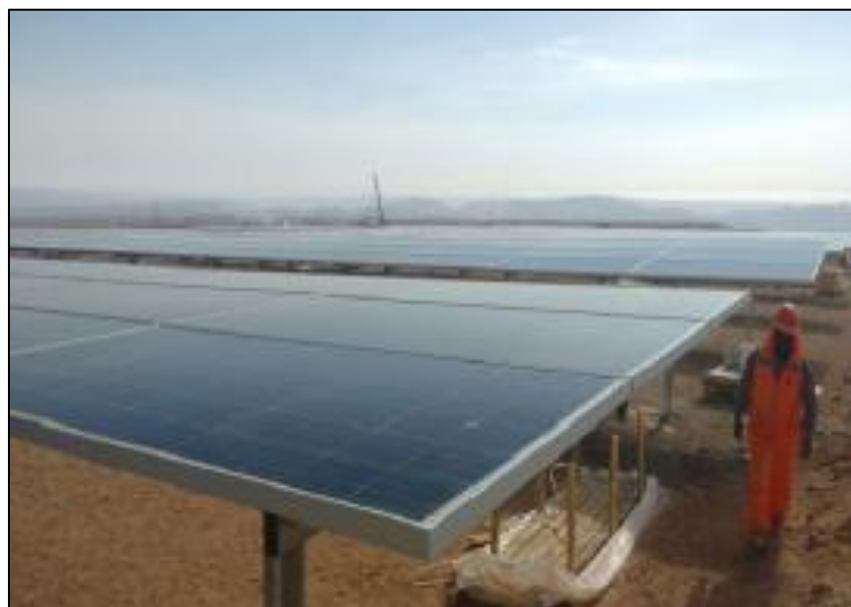
Figura 16: Montaje de paneles solares de la C.S. Intipampa
