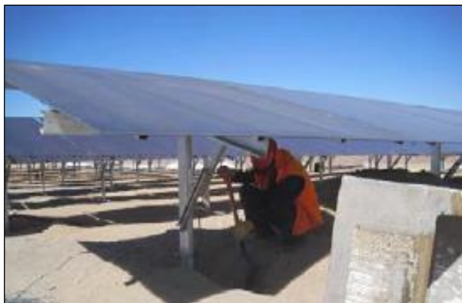
Figura 18: Montaje final de los paneles solares en C.S. Majes
