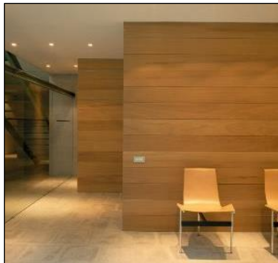
Figura 147: Aplicaciones de machihembrado de madera en tabiques.
