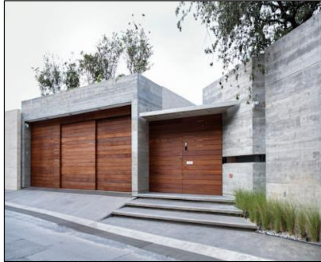
Figura 146: Aplicaciones de concreto expuesto acabado rustico gris.
