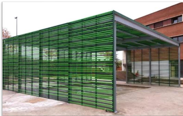
Figura 98: Protección con elementos arquitectónicos de Fachada Sur.
