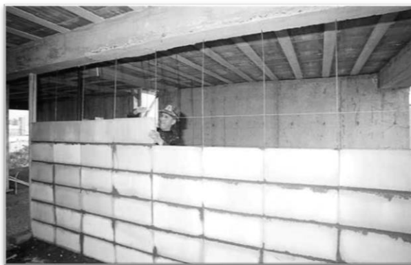
Figura 171: Albañilería armada con ladrillo Silico calcáreos.
