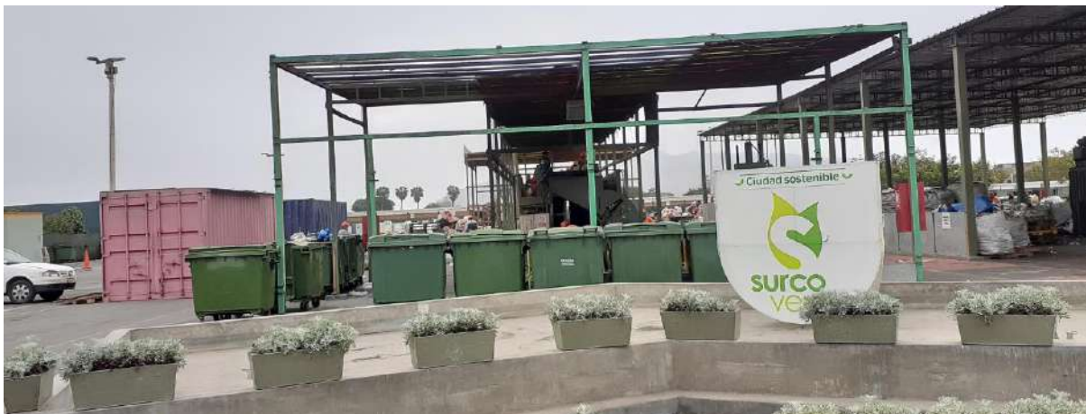
Imagen N° 28. Planta de segregación de residuos inorgánicos del distrito de Santiago de Surco, Lima
