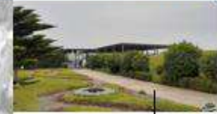
Circulación para el ingreso a la planta de segregación
