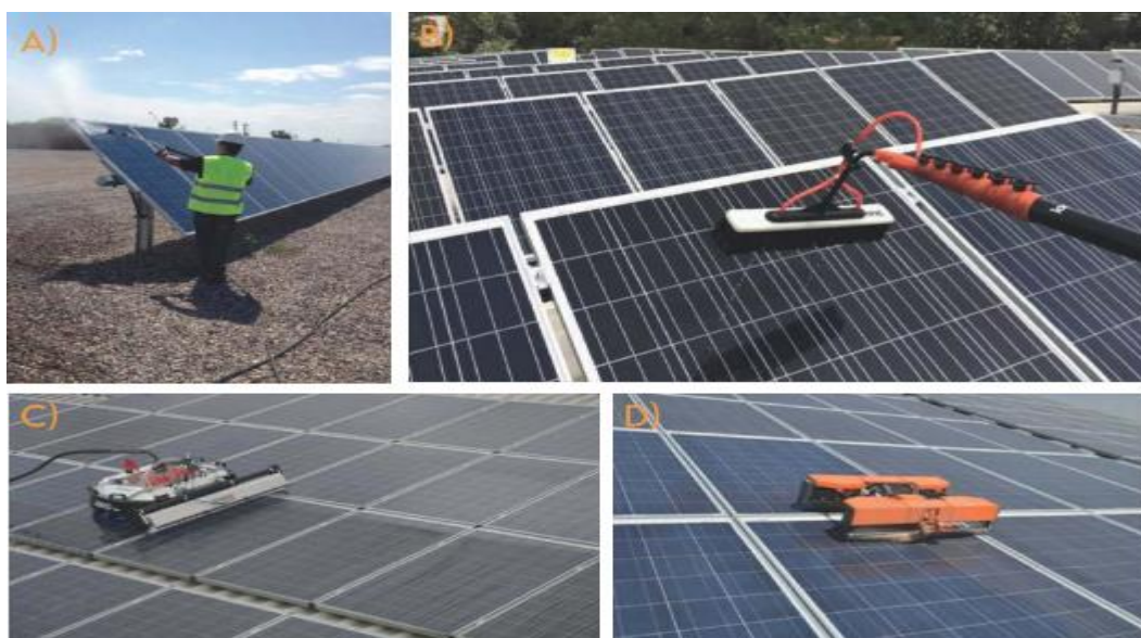
Figura 43. Limpieza de módulos fotovoltaicos.
