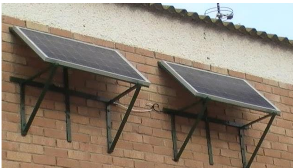
Figura 41. Estructura en la pared.
