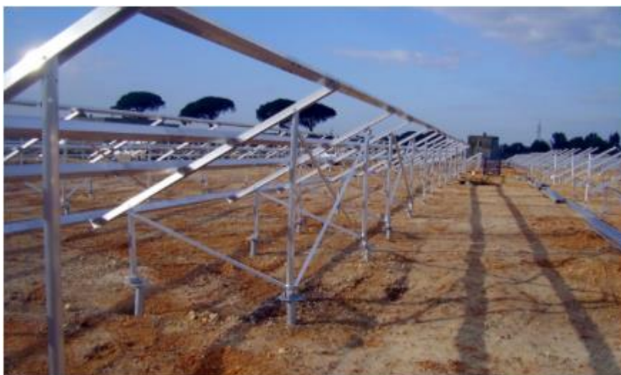
Figura 39. Estructura en el suelo.
