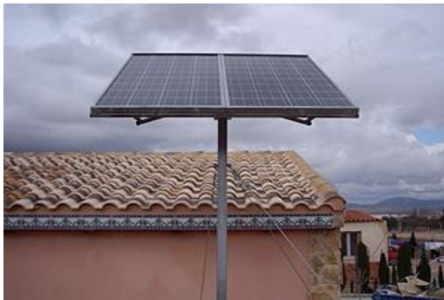
Figura 40. Estructura en poste
