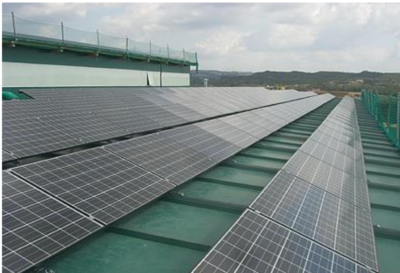
Figura 42. Estructura en el tejado.
