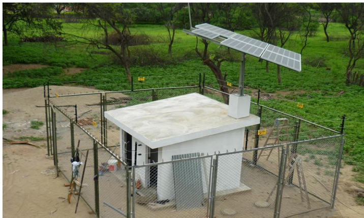
Figura 28: modelo de estructura soporte de panel.
