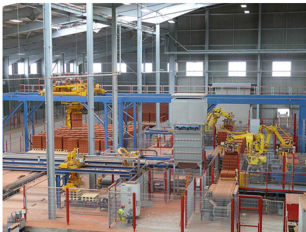
Figura 2.21 Vista parcial del desafilado y empaquetado de ladrillos
