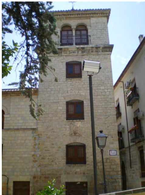
Ilustración 39: Torre del Palacio Episcopal de Jaén.
