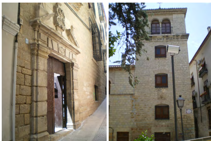
Ilustración 76: Portada y torre construidas durante el episcopado de D. Fray Benito Marín.
