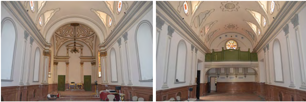
Ilustración 31: Capilla del Palacio Episcopal de Málaga.
