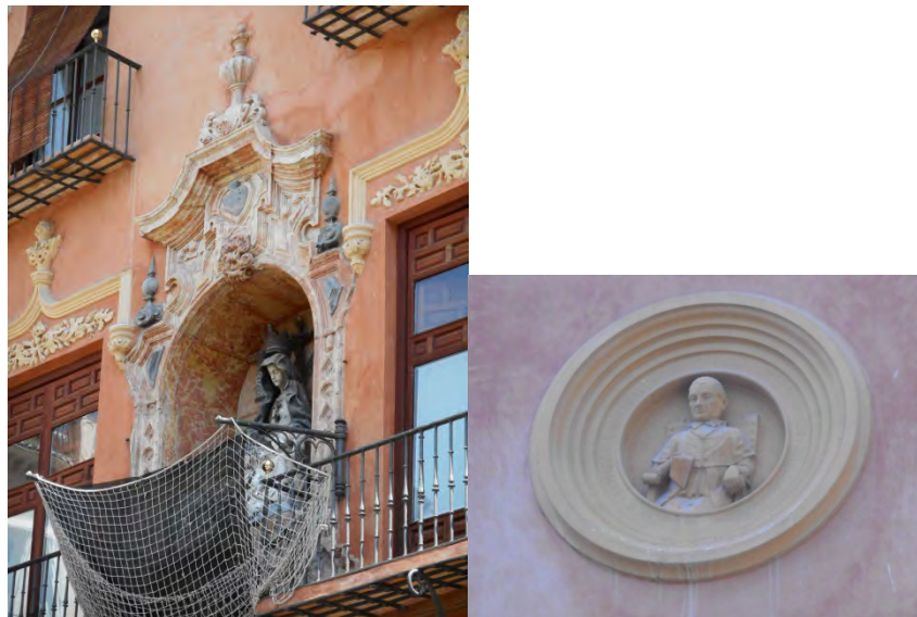
Ilustración 36: Detalle de la hornacina de la Virgen de las Angustias y de uno de los tondos de la fachada principal del Palacio Arzobispal de Granada.
