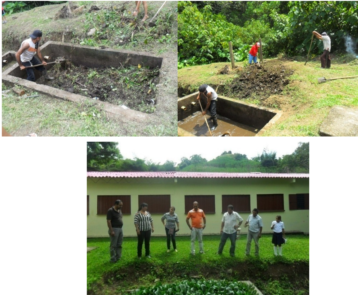
Figura 24. La Planta Increíble, Manos a la Obra.
