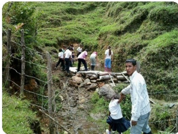
Figura 10. Cercas al lado de la quebrada del acueducto
