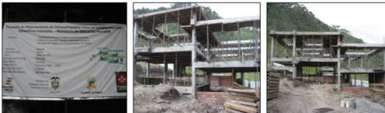
Figura 15. Obras de sede nueva de la I.E. Técnica Ambiental Combeima en Chapetón
