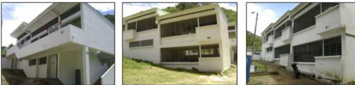
Figura 16. Nueva planta física de la I. E. Técnica Ambiental Combeima en Chapetón.
