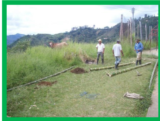
Figura 7. Construcción vivero Los Cedros en la escuela
