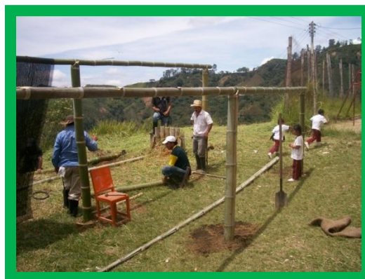
Figura 8. Construcción vivero Los Cedros en la escuela
