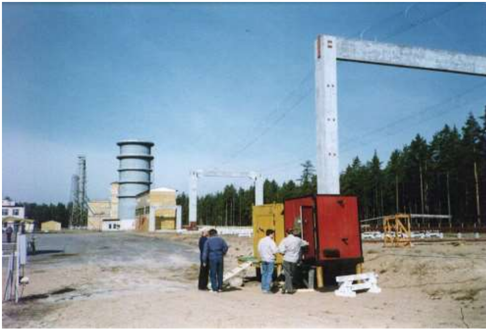
Испытательный комплекс «ЭФЕС» разработки ОКБ ВИТ ХПИ в Ленинградской обл.
