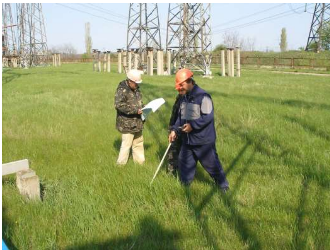
Сотрудники НИО-5 на обследовании заземляющих систем высоковольтных подстанций
