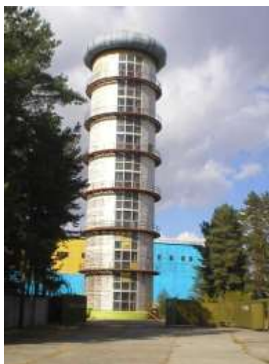
Генератор импульсных напряжений на 14 МВ
