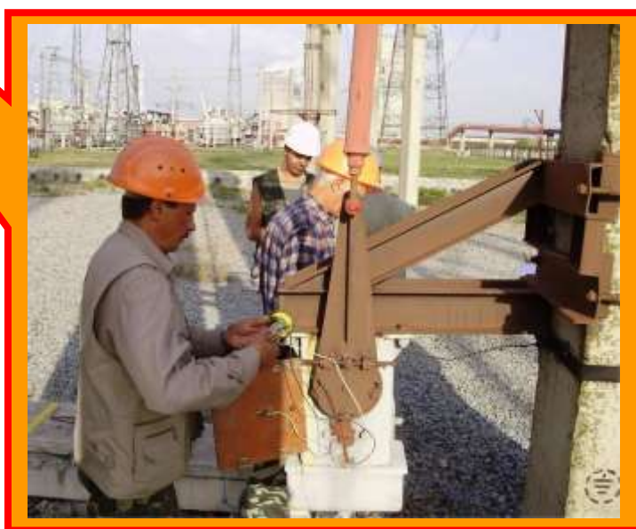
Работы по обеспечению молниезащиты мачт релейной связи
