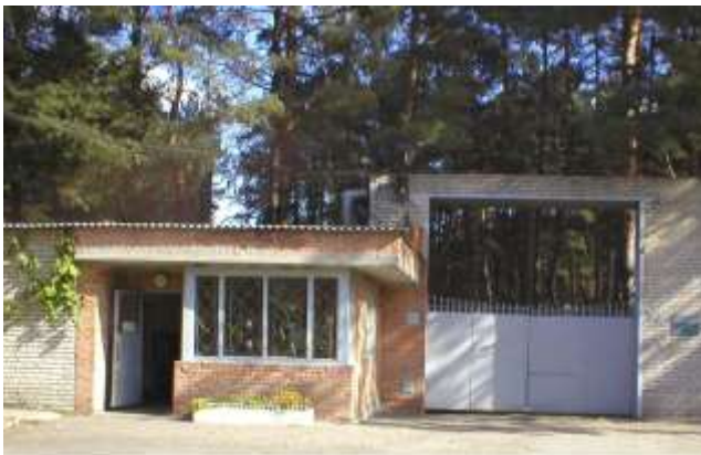
Контрольно-пропускной пункт с АТС
