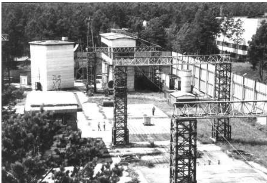
Этапы строительства комплекса ИЭМИ-10М
