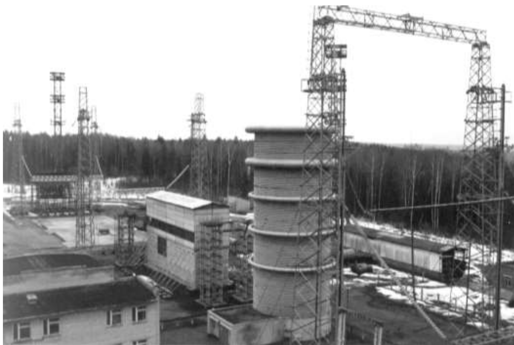
Испытательный комплекс ИЭМИ-6 разработки ОКБ ВИТ ХПИ в г. Загорске Московской обл.
