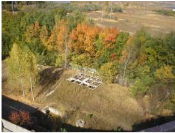
Станция биологической очистки сточных вод
