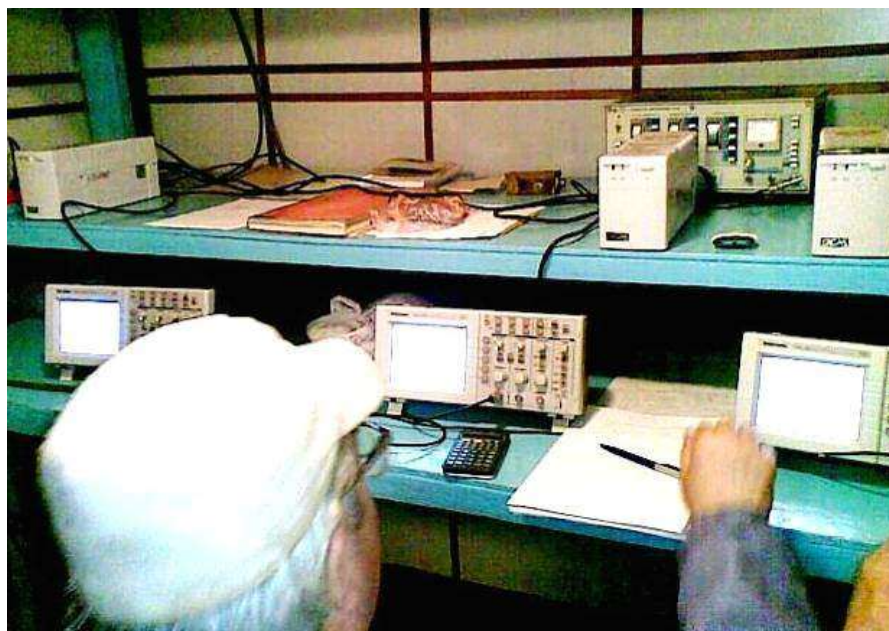
Измерение в бункере с помощью сразу трех временных параметров основных компонент тока молнии в сильноточной цепи ГТМ
