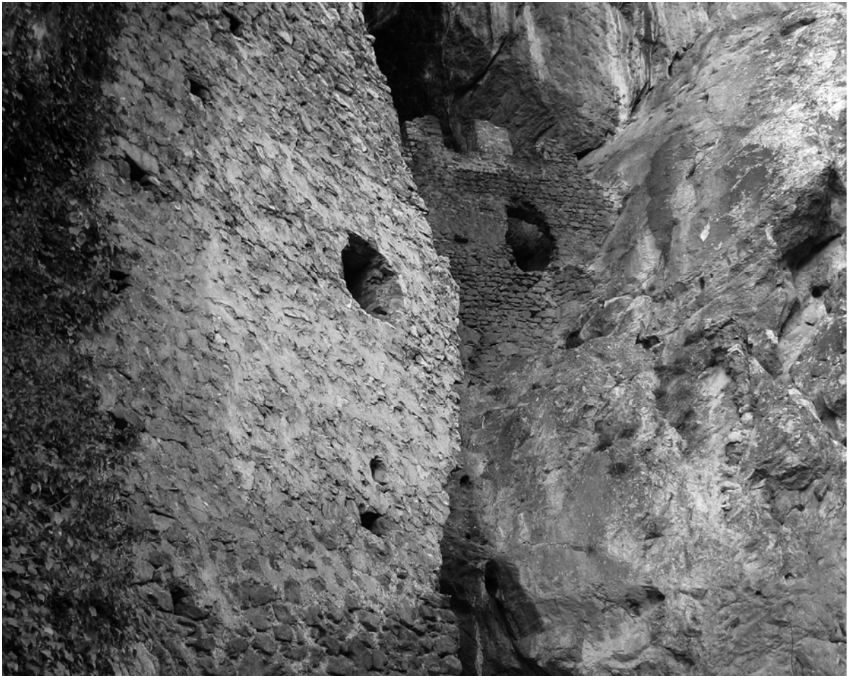
Figure : Spoulga de Bouan (Ariège), grotte fortifiée (fin XIIe s. – XVe s.) : une grotte perchée est barrée d'un mur et une enceinte double celui-ci un peu plus en avant.
