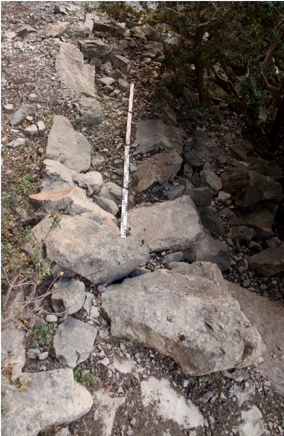
Fig. 7 : Mur à l'entrée du porche de Pladières. Photo Ph. Bence.
