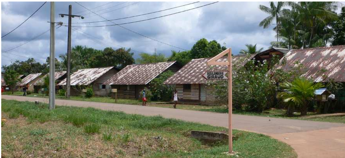
L'alignement des LTS de Village Bambou
