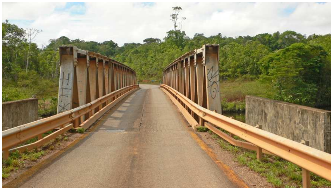
Pont sur la crique Gabaret (PK 180).
