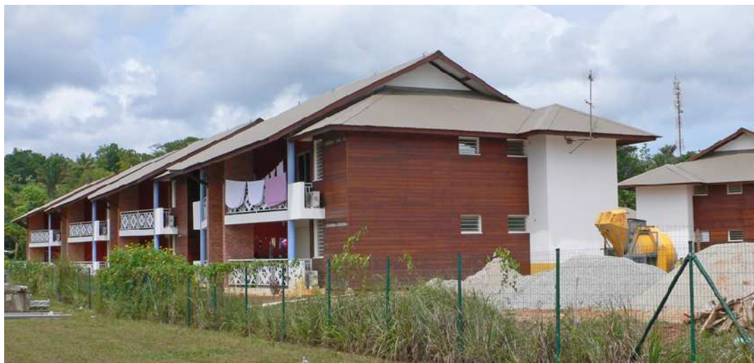
L'opération GABIN, logements réalisés par la SIGUY pour les employés de la PAF
