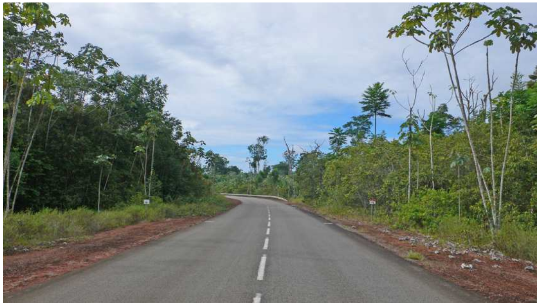
La route au PK 176 (point 1)
