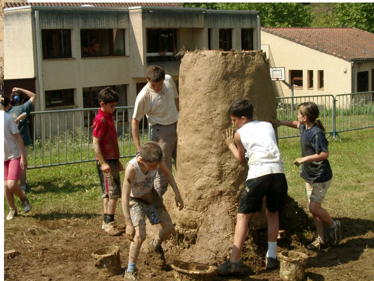
Fig.15B – Bas fourneau de réduction (Fe) en cours de construction. Cahors (Lot) Expérimentation archéologique. (Photographie : D. Morin)
