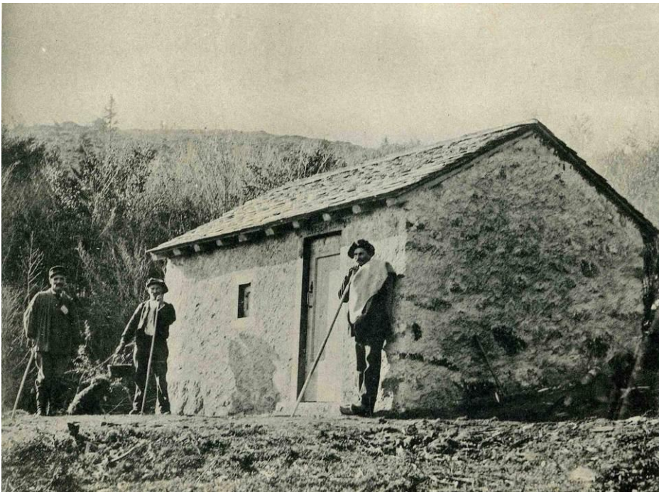
Photo 4 : une des nouvelles cabanes pastorales, construite en 1899 sur les vacants de Perles-Castelet (haute Ariège). (cliché tiré de Buisson, Campardon 1900).
