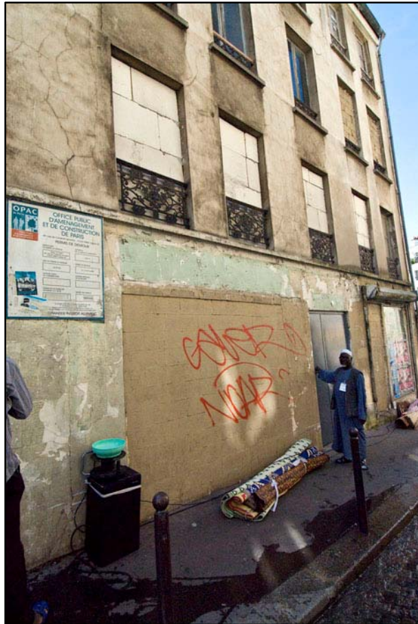
3- Un accès direct à la cave dans l'ancien bâtiment/ © Aunos
