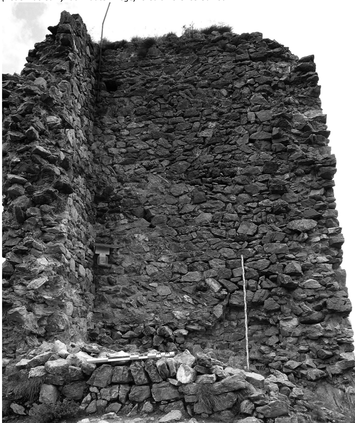
fig. 9 Parement interne de la tour maîtresse du castrum comtal de Montorgueil (Bédeilhac-et-Aynat - haute Ariège). Crédit Florence Guillot.
