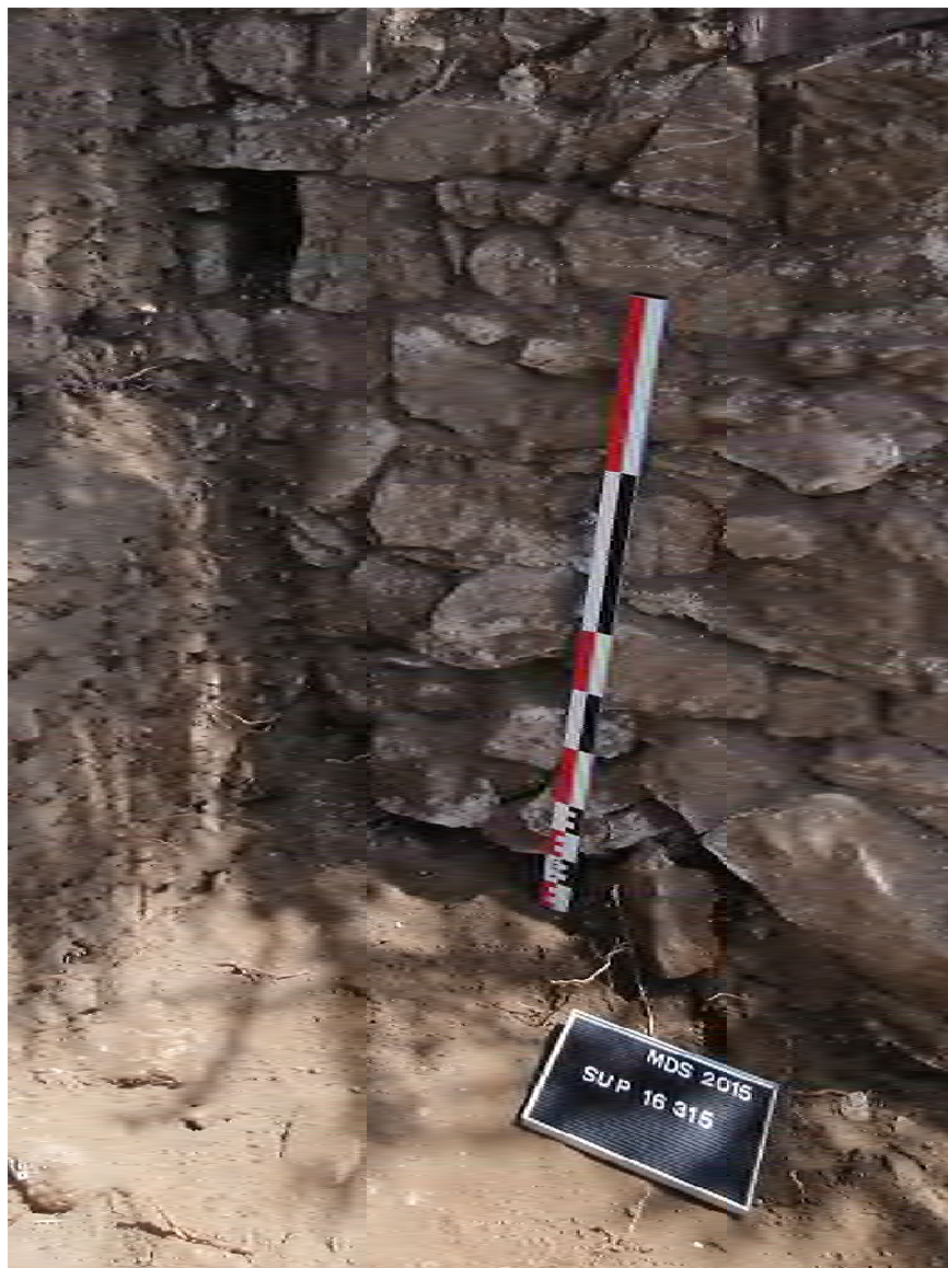
Fig. : Haut de l'Us 16315. Notez que l'on aperçoit le départ (partie haute) d'une reprise en sous-œuvre du M36 qui fut faite lors de son érection, avant que m'on rebouche la tranchée.
