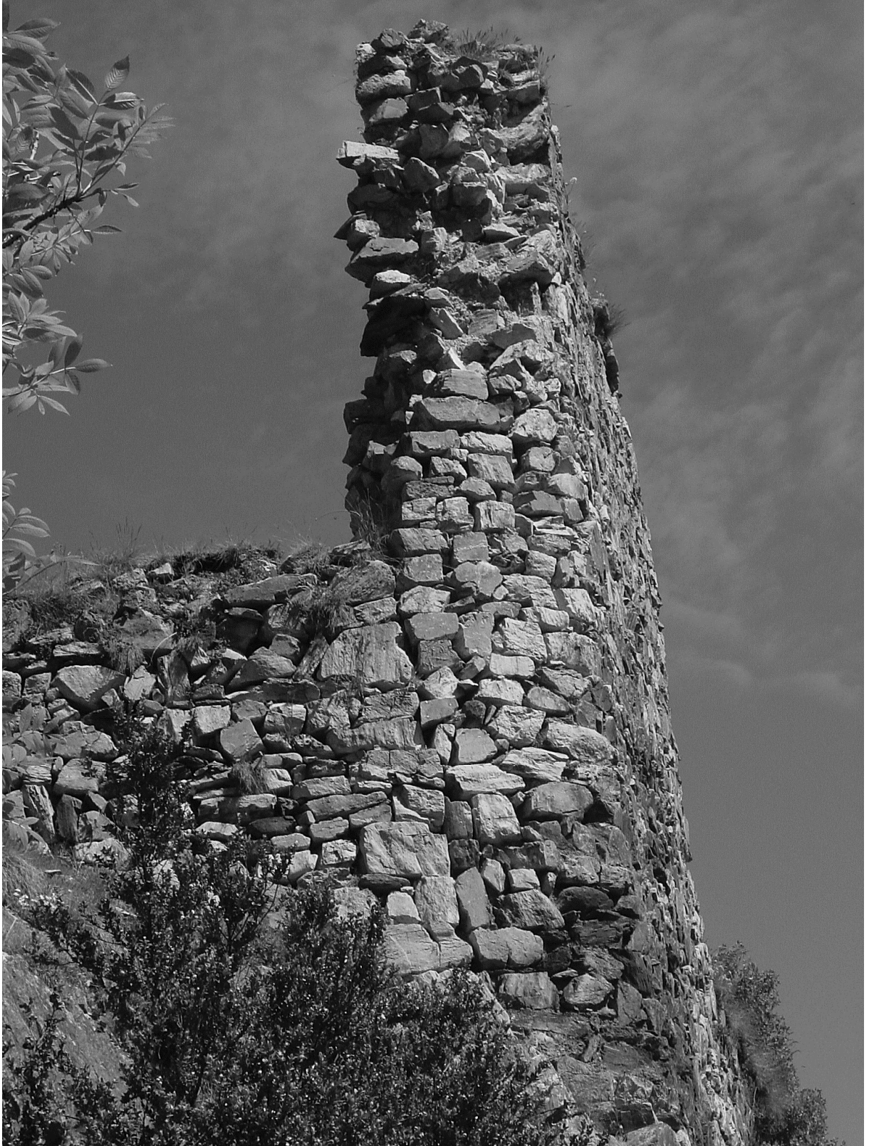
fig. 6. Coup de sabre dans le mur d'enceinte à l'angle formant la tour basse dite du Campanal. Malgré l'absence de chaînage, les murs n'ont pas pu être construits au cours de phases différentes. Il s'agit soit d'une pause de chantier, soit d'une technique volontairement usitée pour éviter que le mur de l'enceinte n'entraîne celui de la tour vers le vide. Crédit Florence Guillot.
