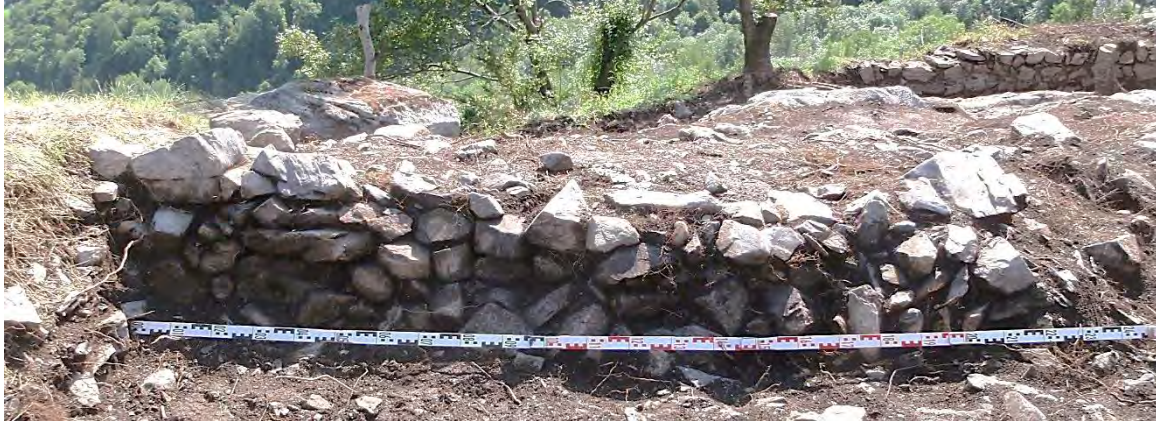
Fig. : M75 avant destruction.
