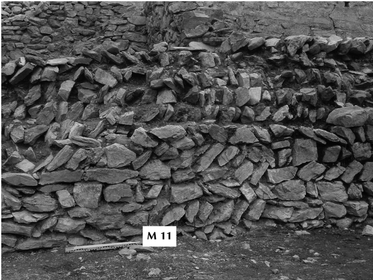
fig. 7 Parement externe et blocage apparent du mur de l'enceinte interne (M 11). Crédit Florence Guillot.
