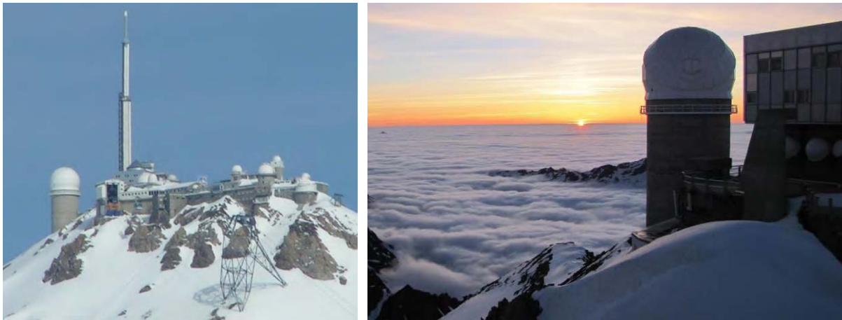
Figure 26 : Vue de l'observatoire du Pic du Midi (gauche) et de la coupole du Télescope Bernard Lyot (droite)
