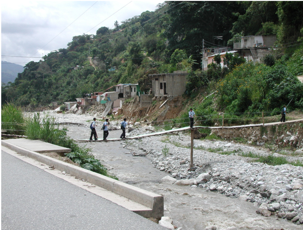
Photo 6c - Habitations détruites par le Mocoties lors de la Vaguada de février 2005
