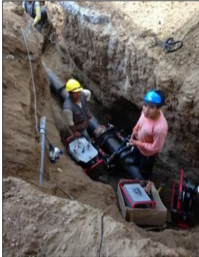
Figura 2. Instalación de línea contra incendios (LCI) – Cencosud – Tienda París Trujillo
