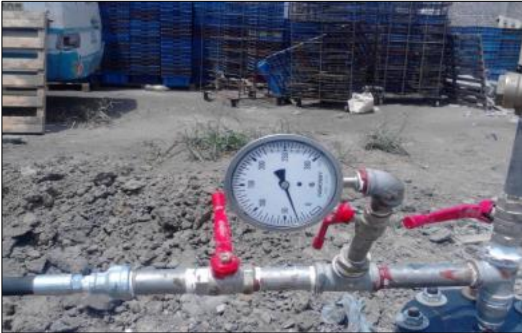
Figura 4. Instalación de línea de gas 4” HDPE – Pesquera Panafood.
