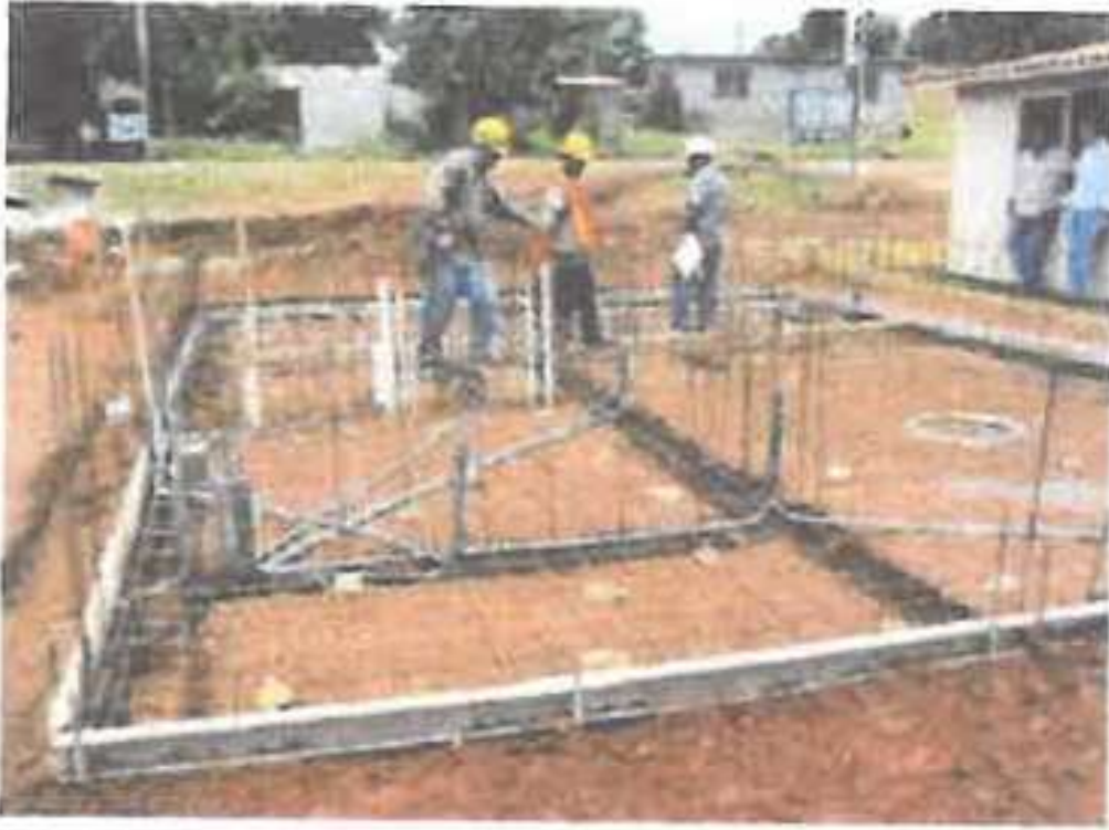
Figura 63. Los ductos de las instalaciones eléctricas y sanitarias coinciden las salidas con los alveolos de los paneles. Fuente: Corporación La Perla.
