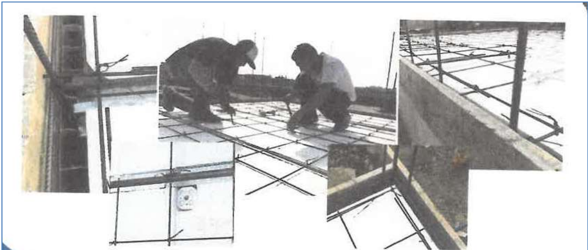
Figura 69. Armado de Techo aligerado. Fuente: Corporación La Perla.
