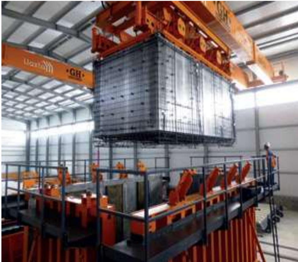
Figura 41. El encofrado de módulo abierto. Los elementos para huecos como ventanas y puertas están fijados al encofrado exterior. Fuente: http://revistapyc.com .
