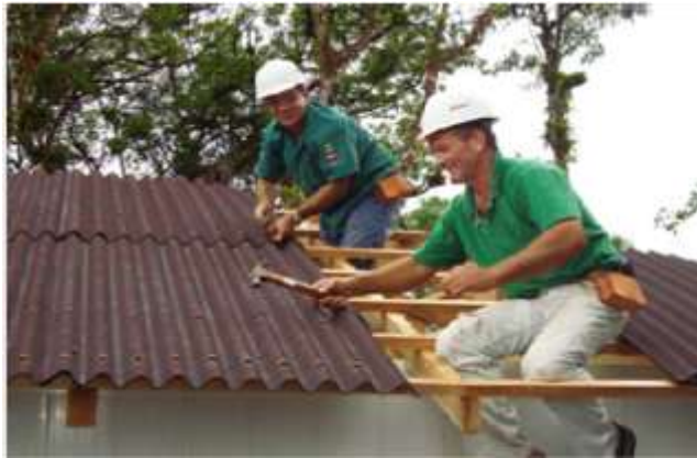
Figura 17. Detalles de colocación del tejado. Fuente: https://www.ghs-housing.com/es
