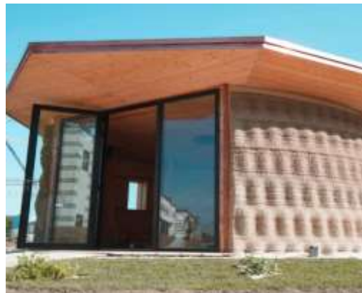
Figura 4. Gaia, primera vivienda impresa en 3D con material ecológico (arroz y tierra), desarrollada por la compañía WASP. Tomada de (WASP, 2019).
