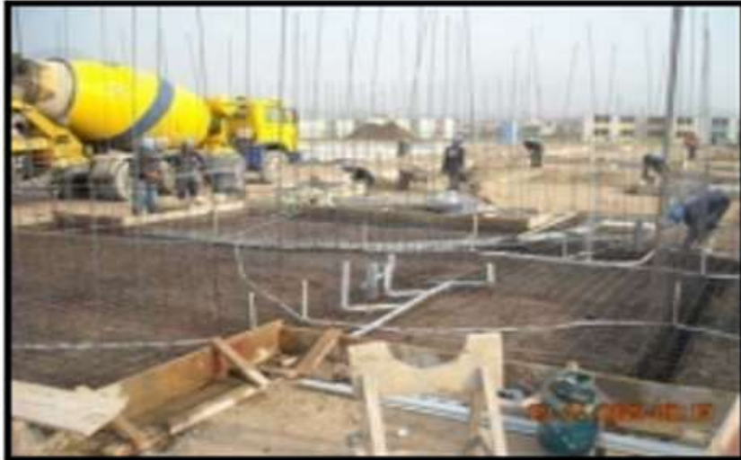
Figura 19. Vaciado de losa de cimentación (plateas). Fuente: http://blog.pucp.edu.pe/blog/wp-content/uploads/sites/109/2009/07/GyM-Construccion-MDL.pdf
