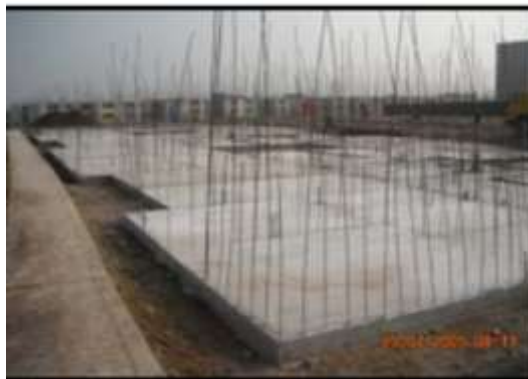
Figura 20. Losa de cimentación terminada. Fuente: http://blog.pucp.edu.pe/blog/wp-content/uploads/sites/109/2009/07/GyM-Construccion-MDL.pdf
