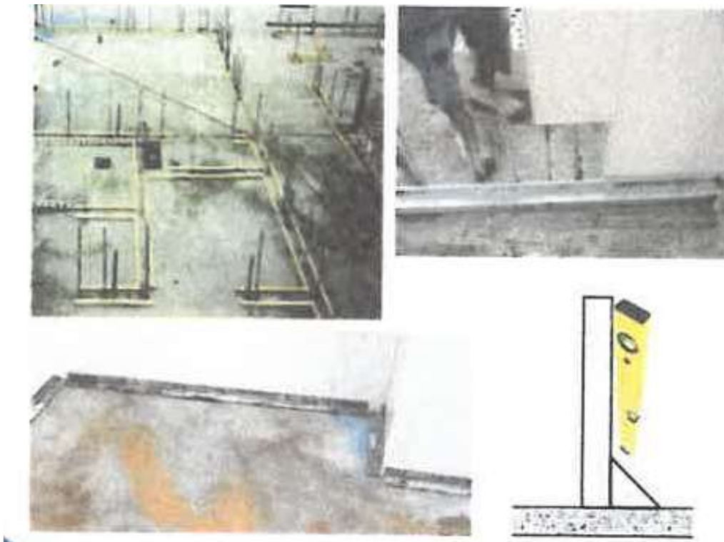
65. Replanteo y fijación de muros sobre la losa de concreto y fijación de guías temporales. Fuente: Corporación La Perla.
