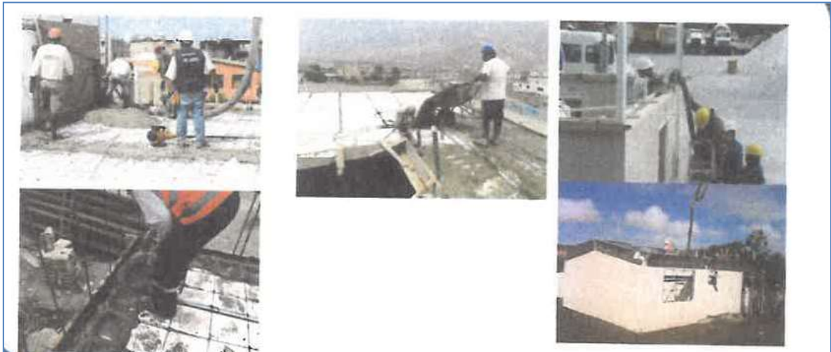
Figura 70. Vaciado de concreto en Techo. Fuente: Corporación La Perla.
