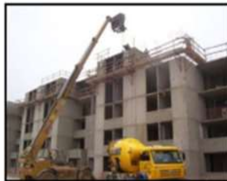
Figura 25. Vaciado con bomba y vaciado con brazo telescópico Fuente: http://blog.pucp.edu.pe/blog/wp-content/uploads/sites/109/2009/07/GyM-Construccion-MDL.pdf
