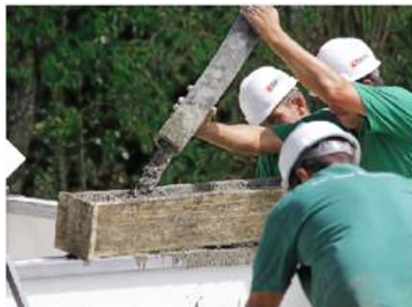
Figura 16. Detalles del vaciado de concreto en paredes. Fuente: https://www.ghhousing.com/es
