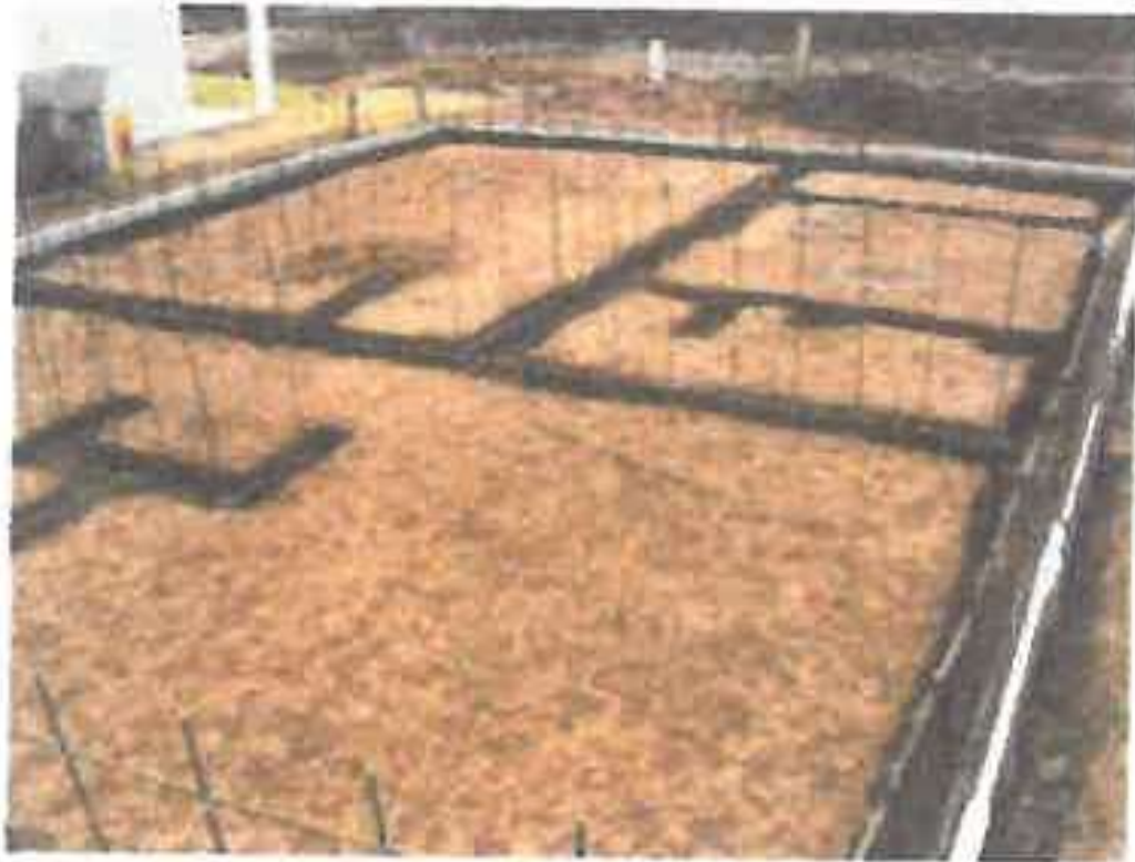
Figura 62. La cimentación es de zapata corrida de concreto armado a lo largo de los ejes de los muros. Fuente: Corporación La Perla.
