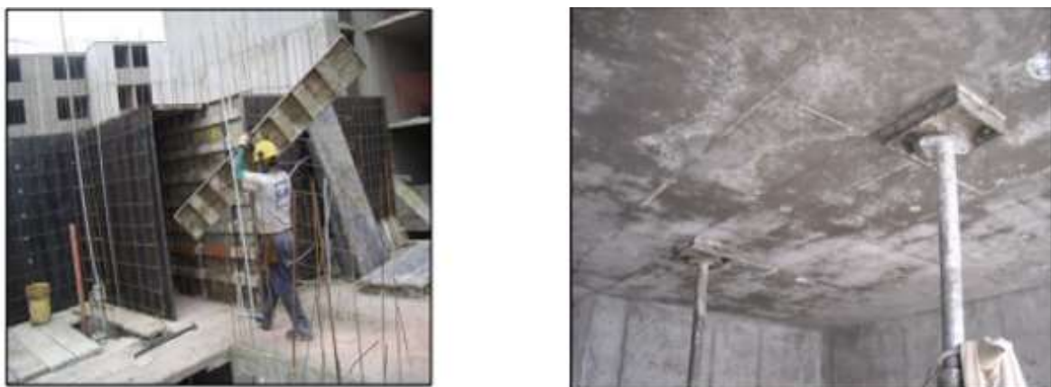
Figura 23. Traslado de formaletas y puntal luego del desencofrado. Fuente: http://blog.pucp.edu.pe/blog/wp-content/uploads/sites/109/2009/07/GyM-Construccion-MDL.pdf
