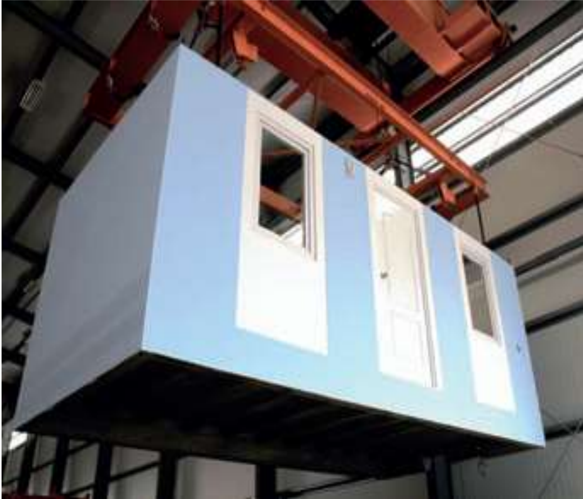
Figura 52. El módulo terminado es transportado a obra listo para su montaje. Fuente: http://revistapyc.com .
