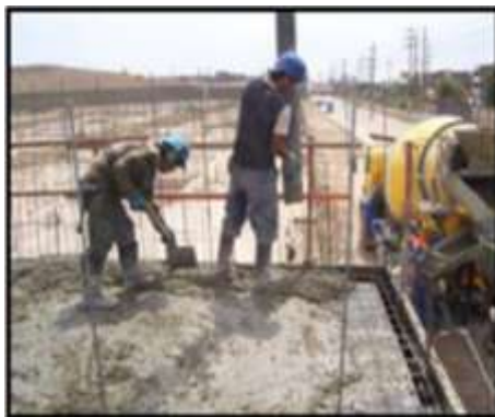
Figura 25. Vaciado con bomba y vaciado con brazo telescópico Fuente: http://blog.pucp.edu.pe/blog/wp-content/uploads/sites/109/2009/07/GyM-Construccion-MDL.pdf
