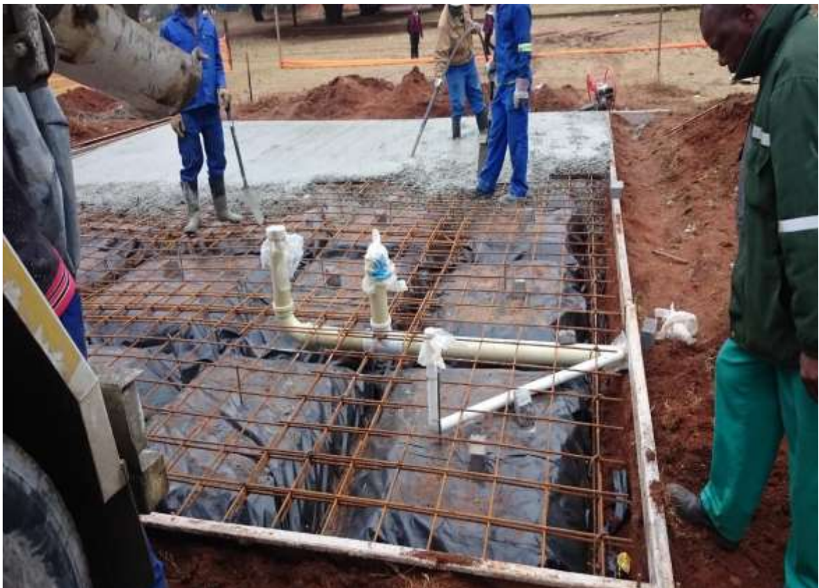
Figura 75. Preparación de cimientos y nivelación del subsuelo. Se coloca el acero corrugado y se tienden tuberías sanitarias. Fuente: https://docplayer.es/15263402-Ghs-permanent-home-otorgamos-un-hogar-a-las-personas-rapido-seguro-simple.html
