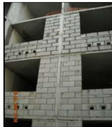
Figura 26.- Separación de \frac{1}{2} ” con tecnopor entre MDL y Ladrillo y fachada con Ladrillo de concreto vibrado P-9. Fuente: http://blog.pucp.edu.pe/blog/wp-content/uploads/sites/109/2009/07/GyM-Construccion-MDL.pdf
