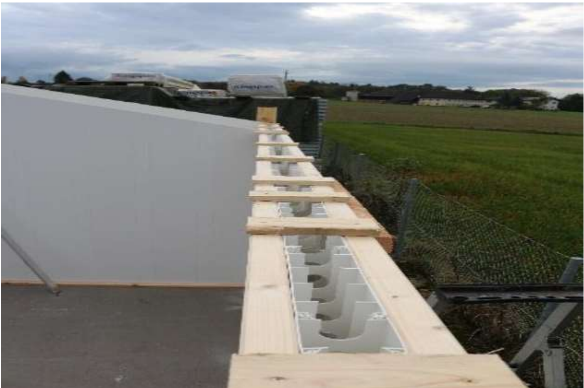
Figura 78. Encofrado de madera en paneles de paredes de PVC.
