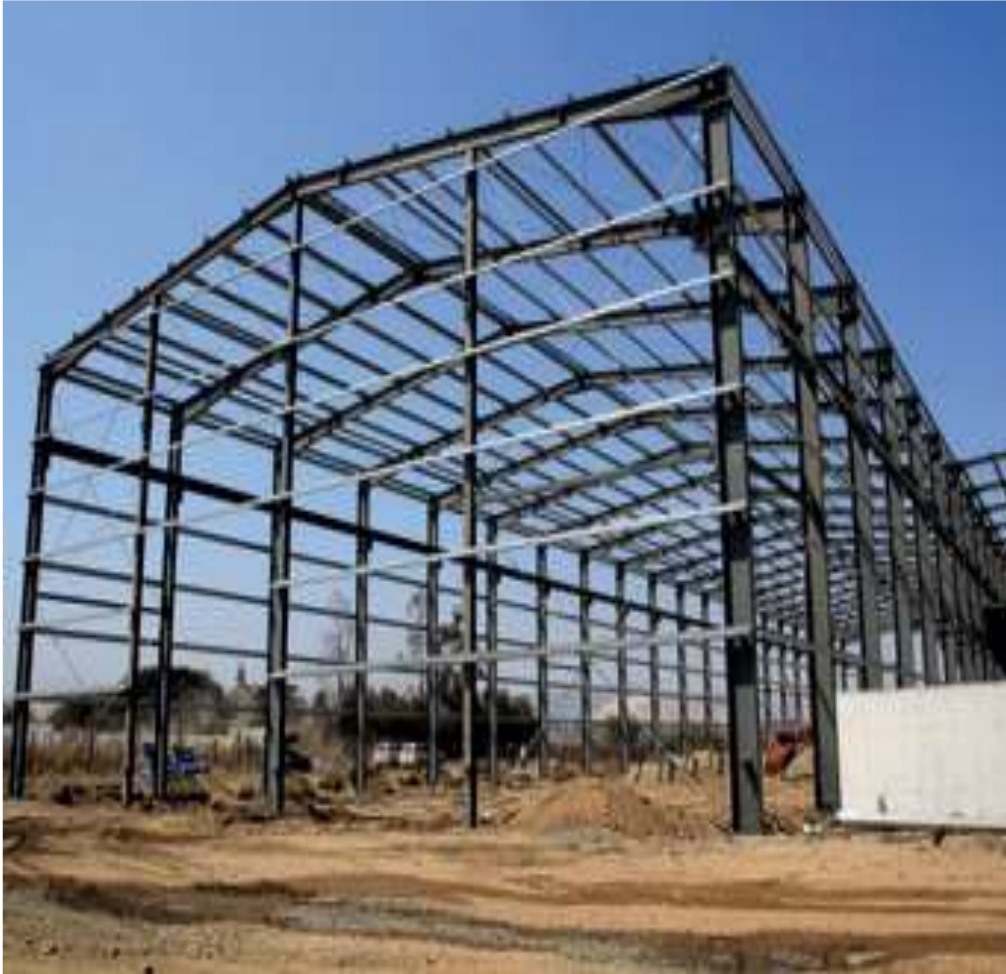
Figura 38. Obra bruta de la nave de producción. Fuente: http://revistapyc.com .
