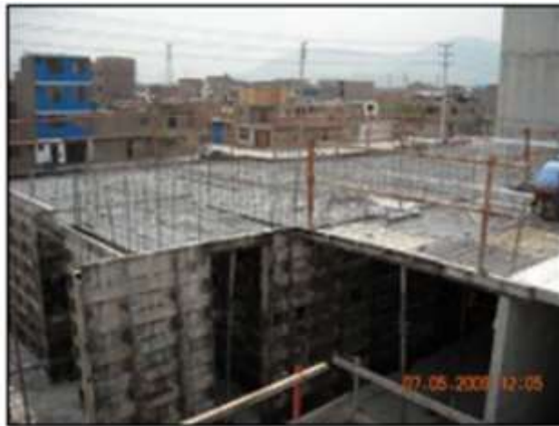
Figura 24. Encofrado monolítico muros y losas. Fuente: http://blog.pucp.edu.pe/blog/wp-content/uploads/sites/109/2009/07/GyM-Construccion-MDL.pdf
