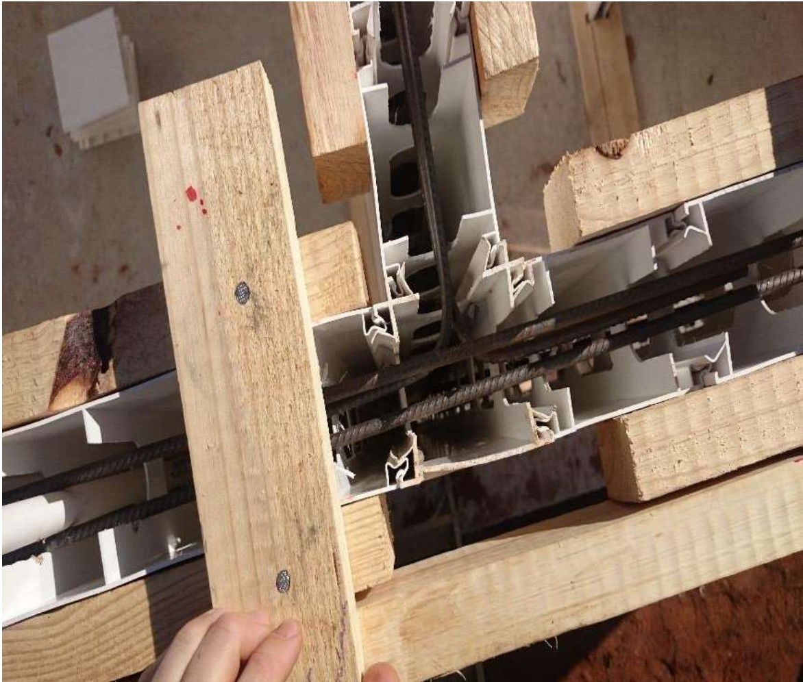
Figura 79. Encofrado de madera en paneles de paredes de PVC y armado del acero corrugado. Fuente: https://docplayer.es/15263402-Ghs-permanent-home-otorgamos-un-hogar-a-las-personas-rapido-seguro-simple.html
