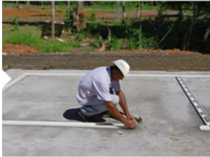
Figura 15. Detalles del proceso del marcado de las paredes en la cimentación. Fuente: https://www.ghs-housing.com/es
