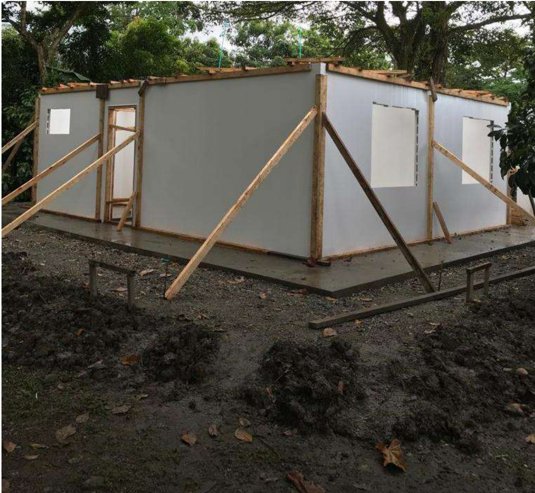
Figura 76. Al colocar los perfiles de pared de PVC, se unen a los cimientos. Fuente: https://docplayer.es/15263402-Ghs-permanent-home-otorgamos-un-hogar-a-las-personas-rapido-seguro-simple.html
