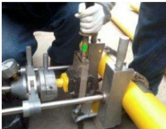
*Figura 16:* colocación de la plancha termofusora
