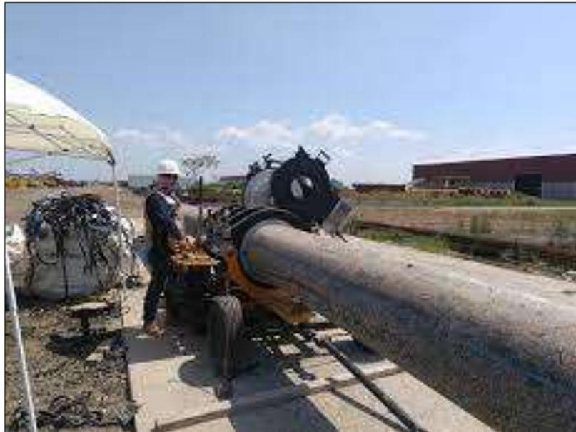
*Figura 25: Inspección visual termofusión.*
