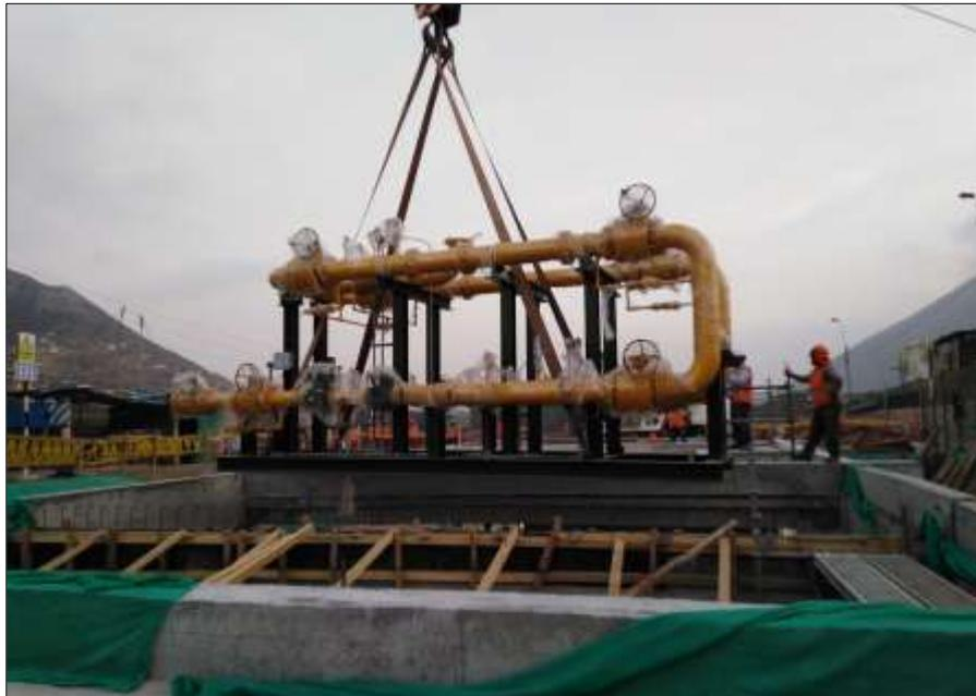
*Figura 12:* Construcción de estaciones de regulación y medición de presión.
