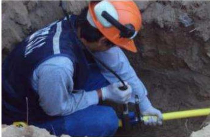
*Figura 15:* Colocación de la plancha calefactora entre la tubería y el accesorio en la termofusión manual a socket.
