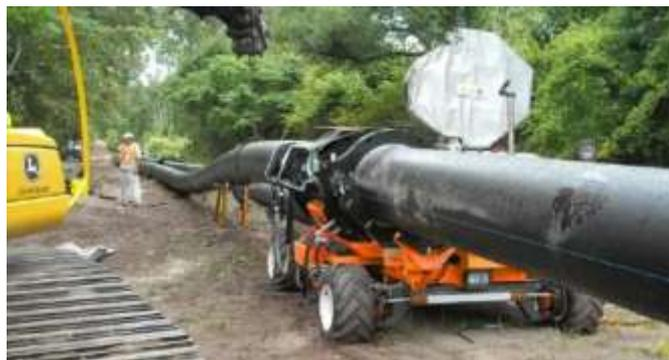
*Figura 21:* Termofusión a Socket en obra.
