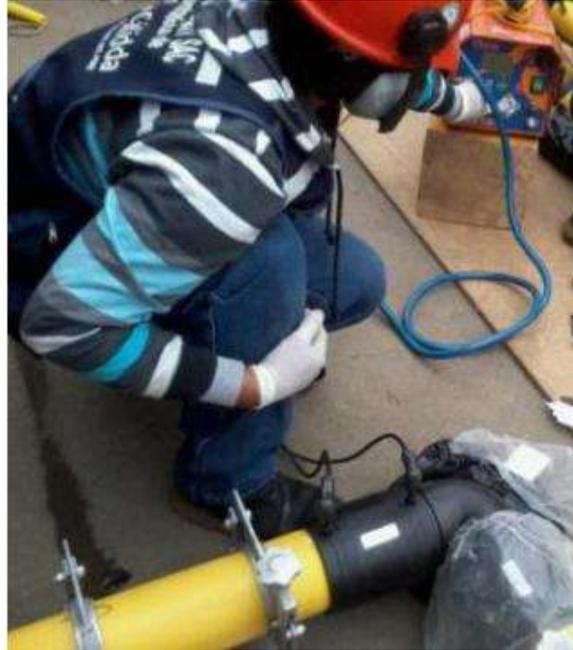
*Figura 13:* Operación de la máquina de control automático para la fusión de un manguito de unión.
