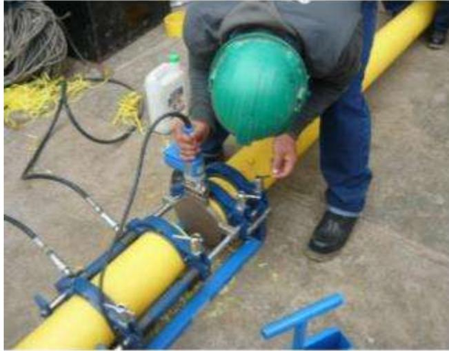
*Figura 14:* Colocación de la plancha calefactora para la termofusión a tope.
