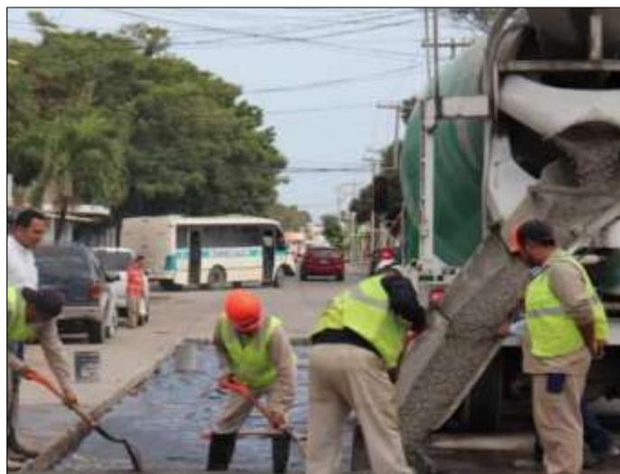
*Figura 24:* Reposición de pavimento.
