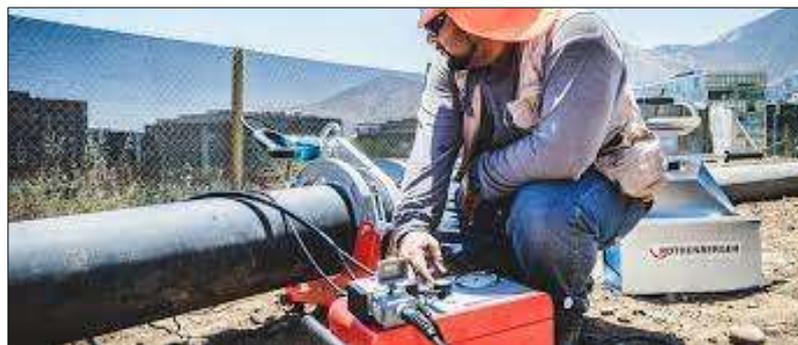
*Figura 26: Inspección visual termofusión.*
