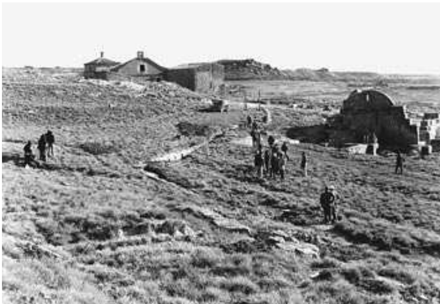
FIG. 24. Muro de contención abierto en ángulo obtuso entre las lomas del pie del Puy de Los Bañales y las termas en marzo de 1973 (Foto: A. Beltrán).
