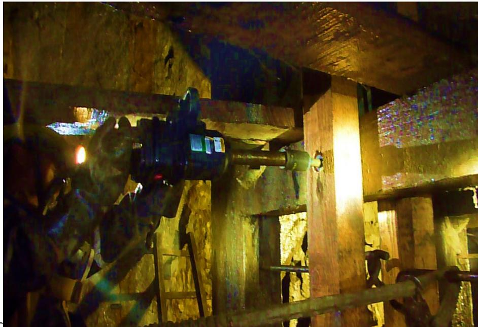
*Figura N18 Instalación de guías con equipos de poder*
