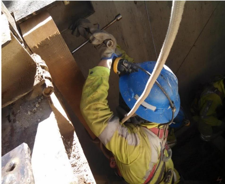
*Figura N17 Instalación de guías con llaves.*
