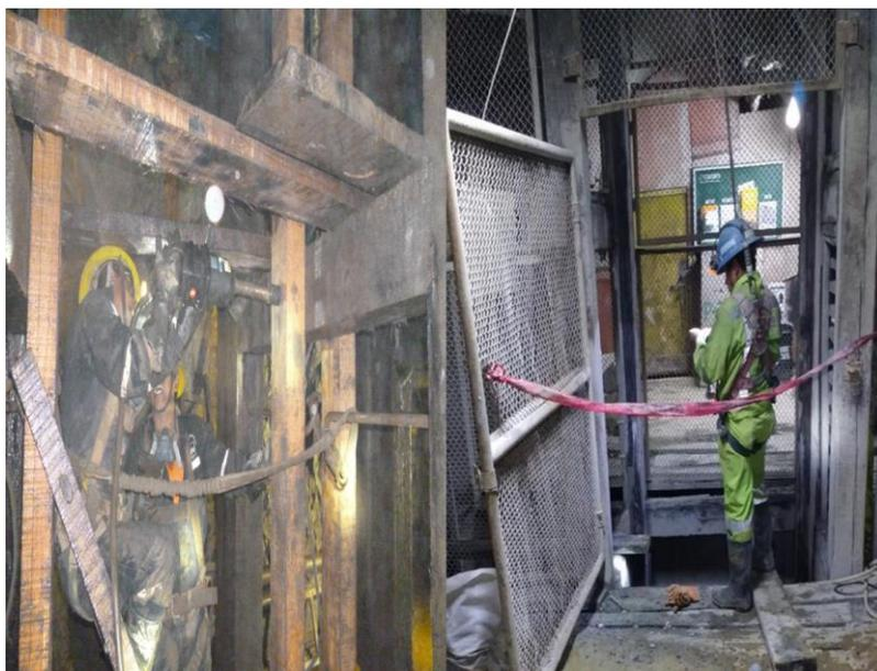
*Figura N4: Instalación de guías y izaje de carga mediante plataformas provisionales de tablas*
