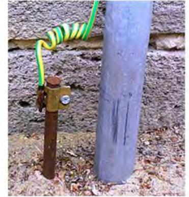
Varilla usada como electrodo de tierra. El cable color ver-amarillo designa el cable de tierra.
