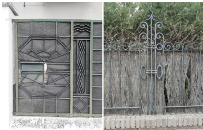
Figura 8. Ejemplos de rejería en el cerramiento de la parcela de dos viviendas situadas en la calle José Torán.
