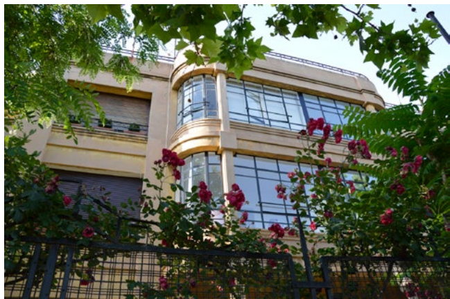
Figura 7. Carpintería exterior del edificio de viviendas sito en la calle Fernando Hué 4 (1934).
