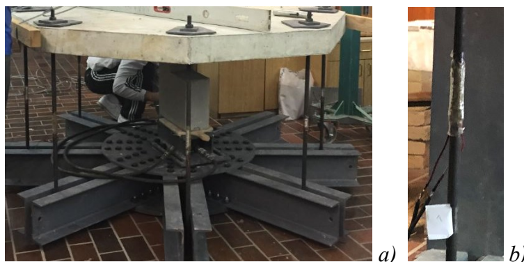
Slika 67: Postavljanje vijaka i položaj mernih traka na njima
