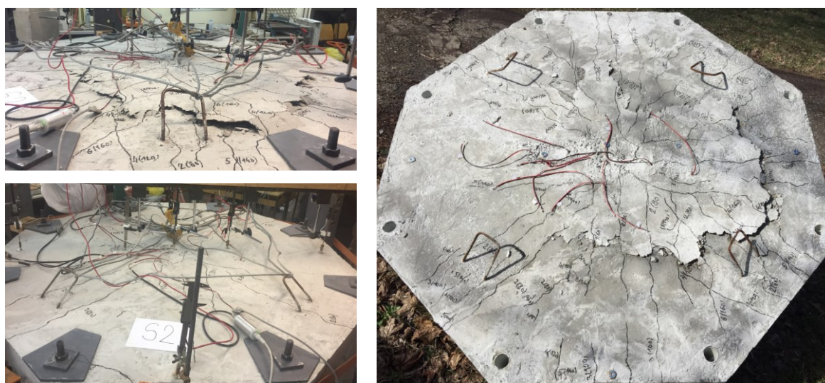
Slika 86: Raspored prslina na zategnutoj površini ploče S2
