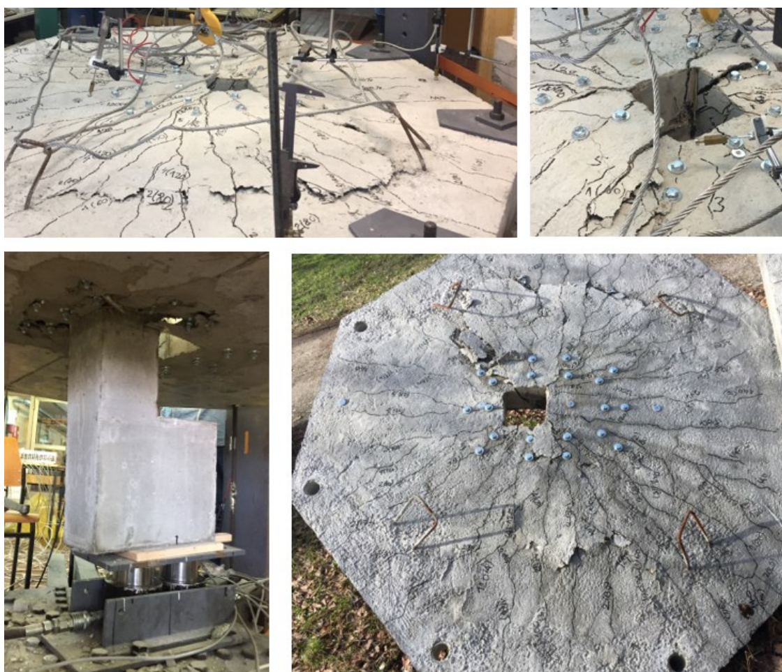
Slika 98: Raspored prsline na zategnutoj površini ploče S8
