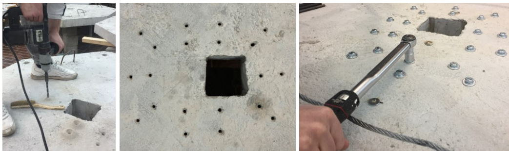
Slika 80: Bušenje rupa i prednaprezanje vijaka u ploči S8
