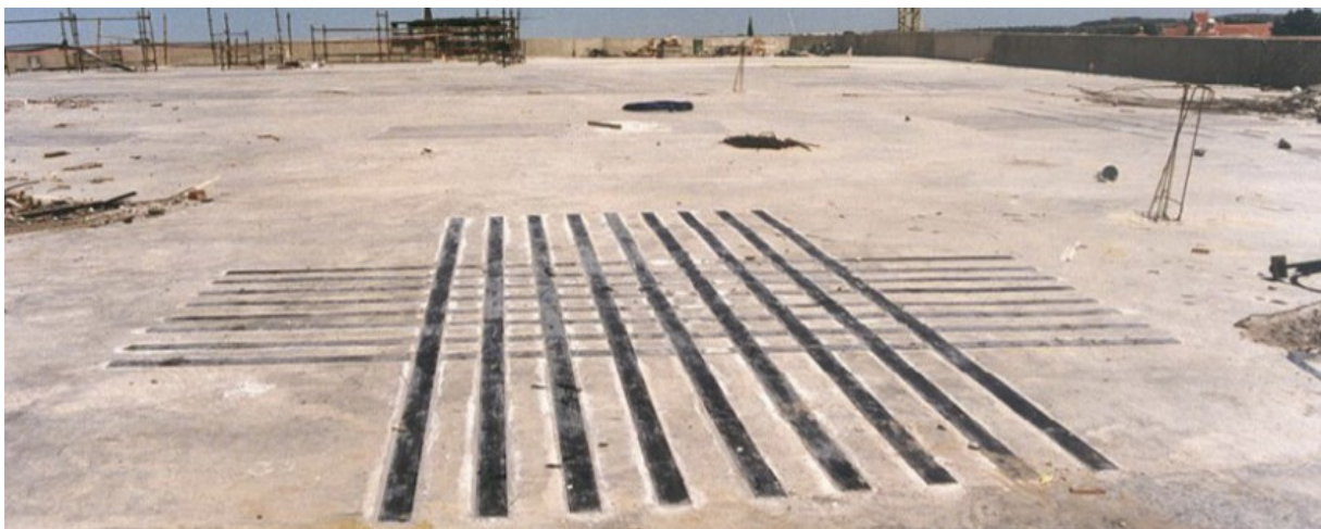
Slika 14: Ojačanje postojećih armirano betonskih ploča karbonskim trakama [36]
