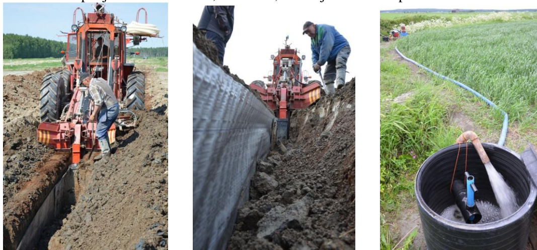
Kuva 1. Muovin asentaminen 1,8 m:n syvyyteen salaojakoneeseen rakennetun lisäosan avulla. Oikealla lisäveden pumppaus läheisestä ojasta. Kuvat: Rainer Rosendahl, ProAgria Österbottens Svenska Lantbrukssällskap
