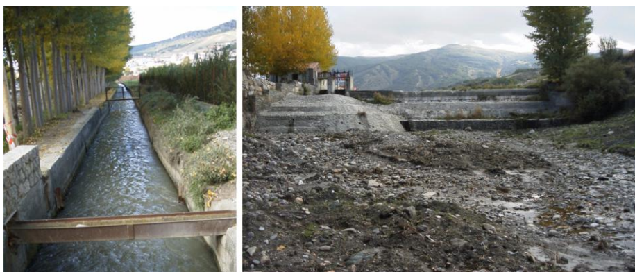
Fig. 6. Imagen actual de la presa de la Acequia Gorda (derecha) y del canal de derivación que parte de ésta (izquierda).
