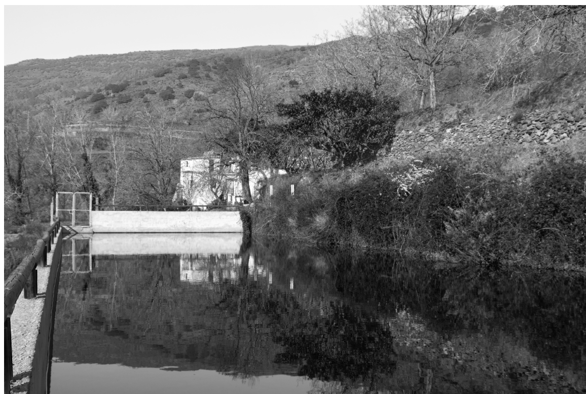
Fotografía 12. Vaso principal de la Alberca del Molino lleno de agua. Al fondo, Molino del Tío Ramblero.
